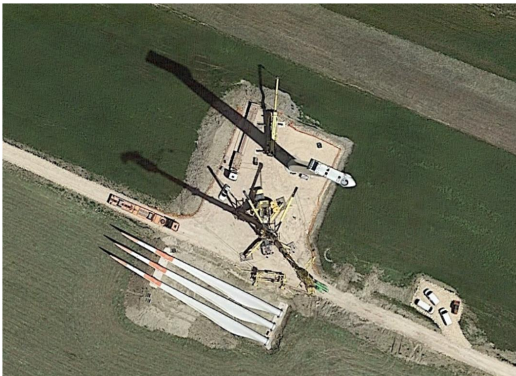
Figura 2.1 – esempio di piazzola in fase di costruzione
