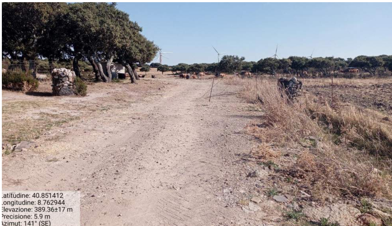
Figura 5.17 – Parte della viabilità esistente da adeguare di collegamento alla postazione eolica T14 (direzione sud-est)
