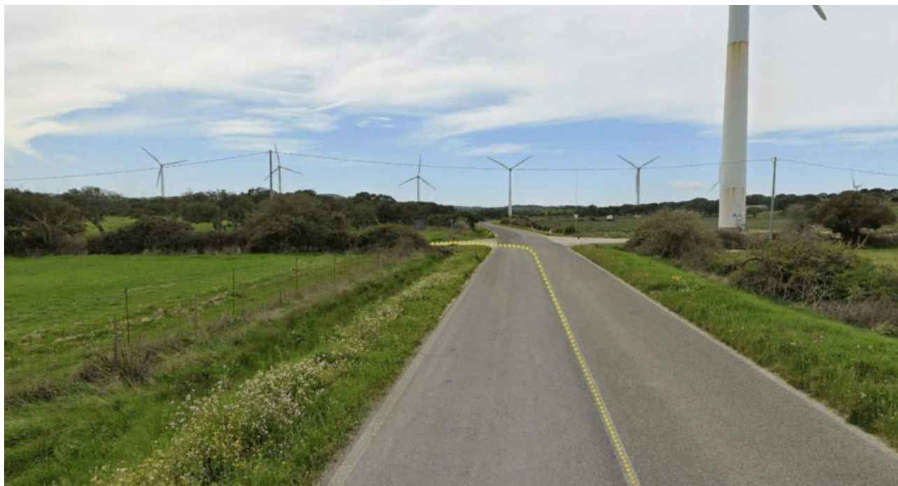
Figura 8.10 - Punto di innesto tra la SP 143 e la viabilità secondaria di accesso al cluster 1
