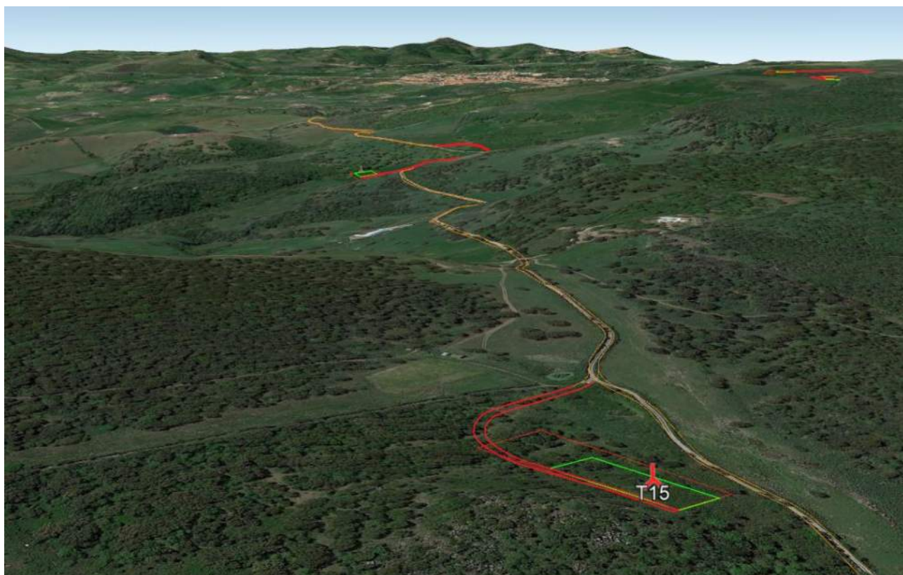
Figura 5.50 – Asse di collegamento alla postazione eolica T15 (vista verso nord-ovest)
