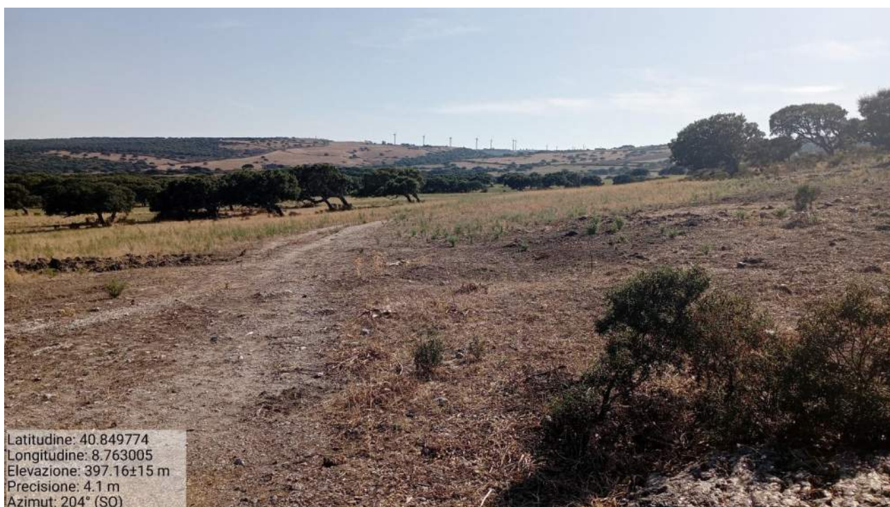
Figura 5.18 – Terreni attraversati dalla viabilità di nuova costruzione (direzione sud-ovest)
