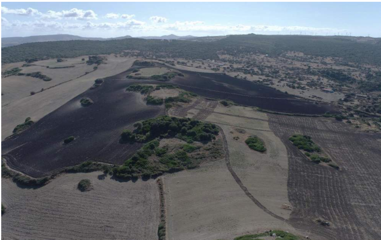
Figura 8.9 – Veduta dell’area di installazione della postazione eolica T13 all’interno del cluster meridionale dell’impianto. Ripresa aerea da est verso ovest
