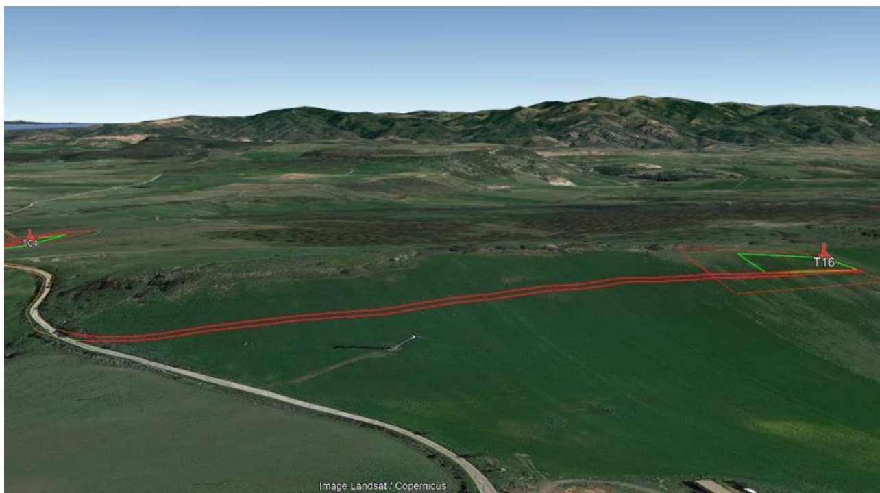
Figura 5.11 – Tracciato di collegamento alla postazione eolica T16 (vista verso nord)
