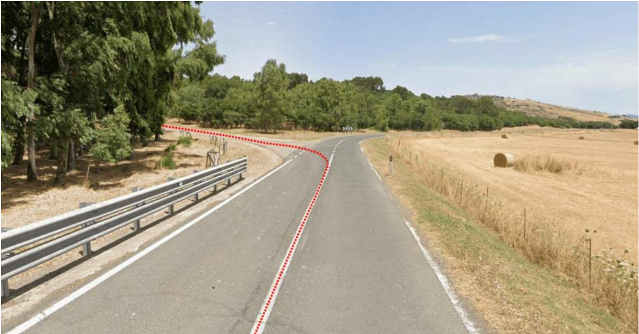
Figura 8.14 - Punto di innesto tra la SS 127 e la viabilità secondaria di accesso al cluster 4 nei pressi di T11
