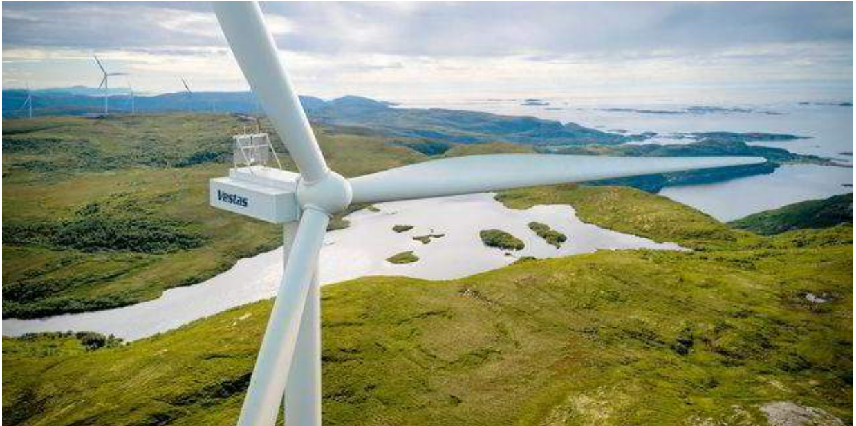
Figura 5.3 – Aerogeneratore Vestas Enventus
