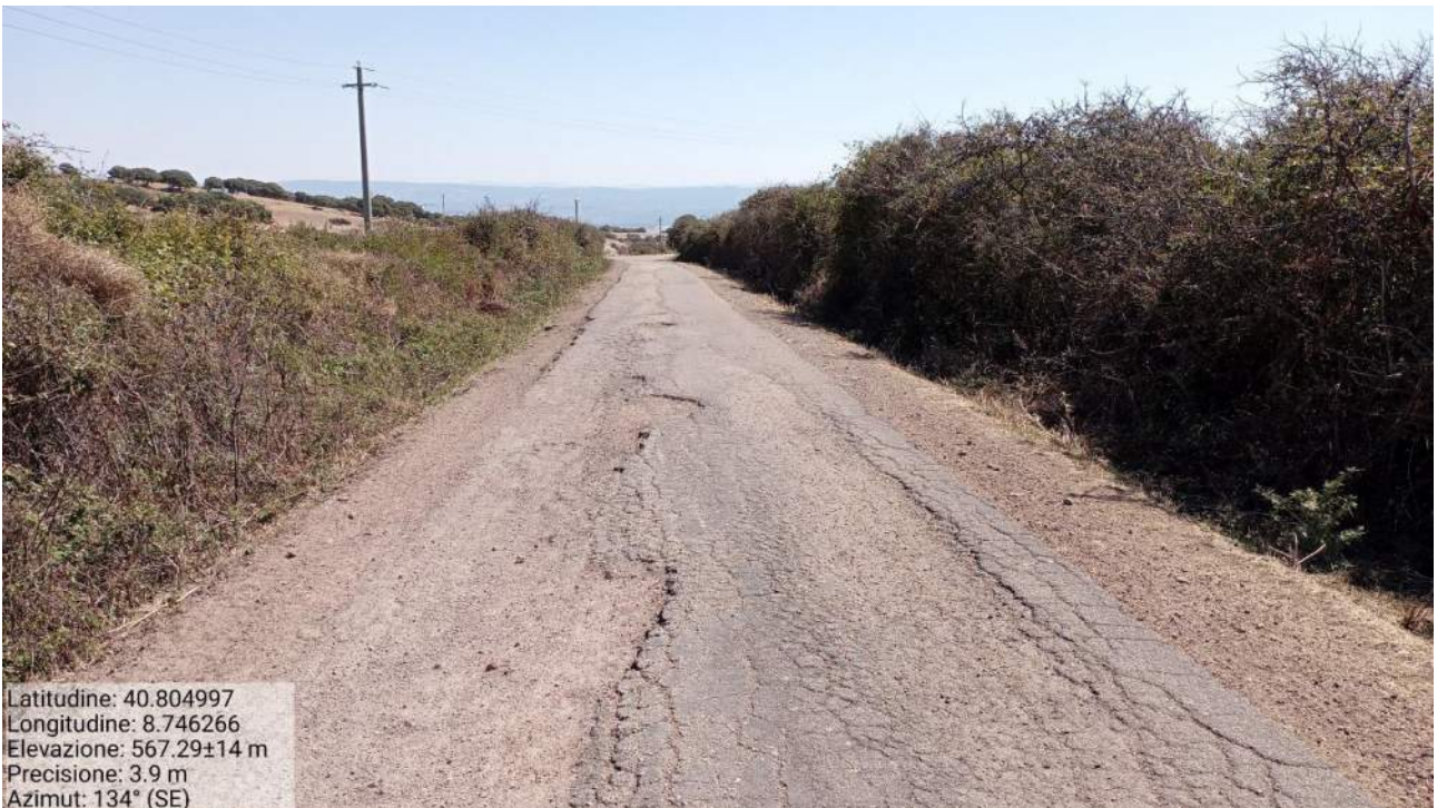
Figura 5.27 – Viabilità rurale esistente di accesso al Cluster 3 (direzione sud-est).
