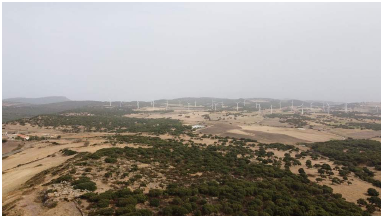
Figura 8.6 – Vista sull'area di installazione di T01, nella porzione settentrionale dell'impianto. Ripresa aerea da sud-ovest verso nord-est
