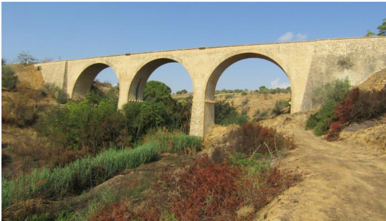
Figura 7 – Intervento su Viadotto VI04 – ante operam - (stralcio Elaborato RS6K00R22EXIM0002002A)
