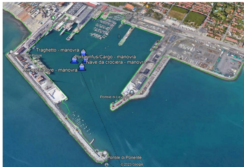
Figura 10.6: Sorgenti in manovra stato attuale
