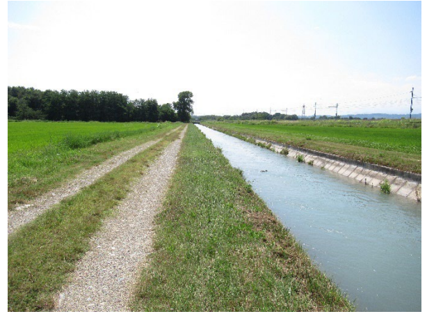
Figura 18 – Tratto sterrato a fianco del canale
