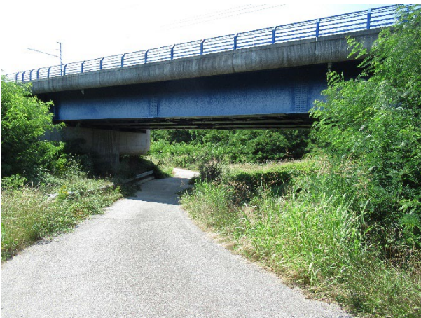
Figura 15 – Sottopassaggio ferrovia Vanoni
