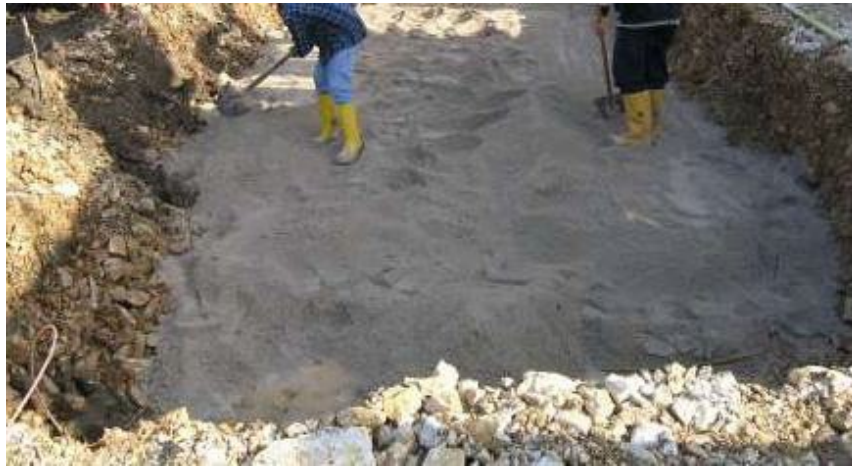
FIGURA 32 - SBANCAMENTO PIANO POSA CABINE
