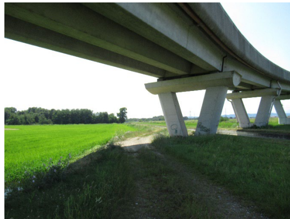
Figura 19 – Tratto sterrato al di sotto del cavalcavia
