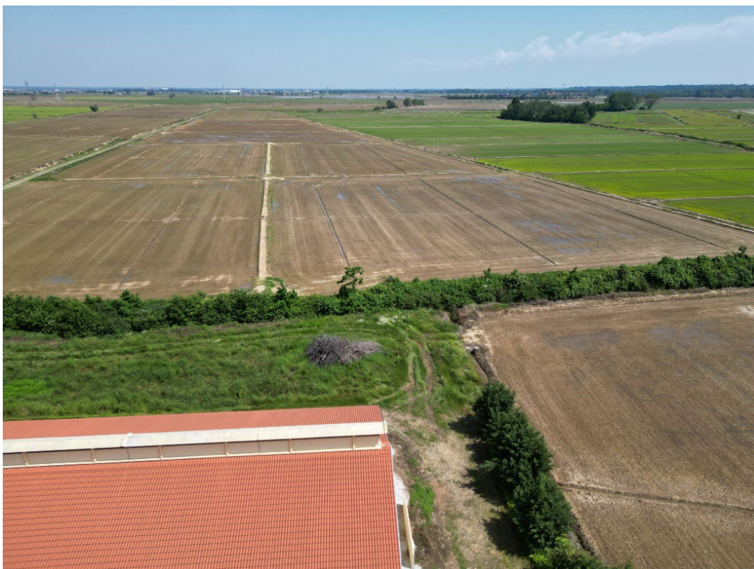
Figura 8 - vista da cascina Madama lato sud-est
