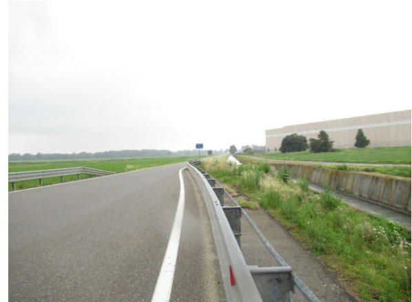
Figura 21 – SP 55 in prossimità della
