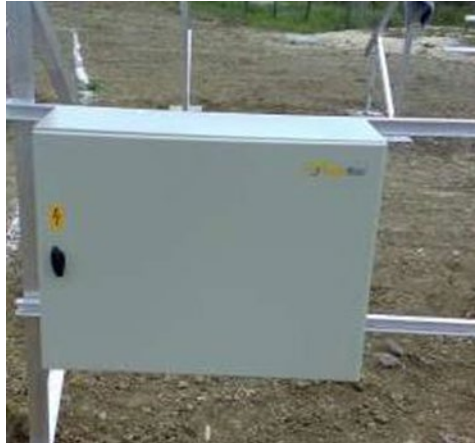
FIGURA 38 - QUADRI IN PARALLELO
