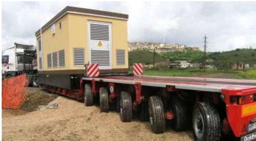
FIGURA 35 - INSTALLAZIONE CABINE
