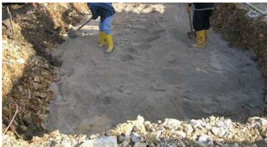
FIGURA 32 - SBANCAMENTO PIANO POSA CABINE
