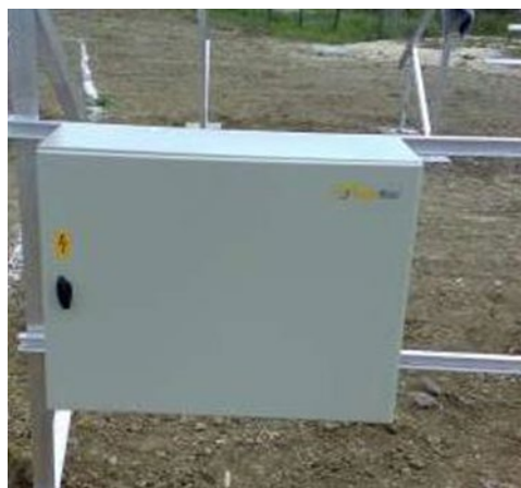
FIGURA 38 - QUADRI IN PARALLELO
