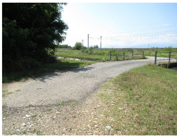
Figura 16 – Tratto che sorpassa il canale Vanoni
