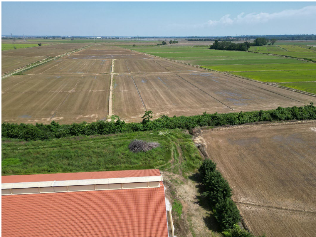
Figura 7: Vista da cascina Madama lato sud-est
