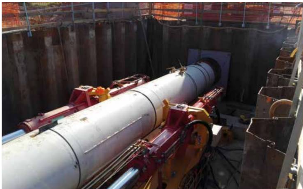
Fig. 2/E: Postazione di spinta con TBM posizionata e pronta per la perforazione
