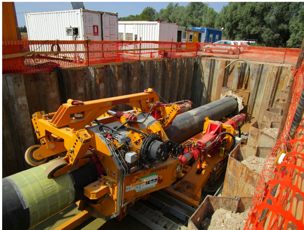
Fig. 2/F: Apparatto di spinta (Pipe Ttruster)
