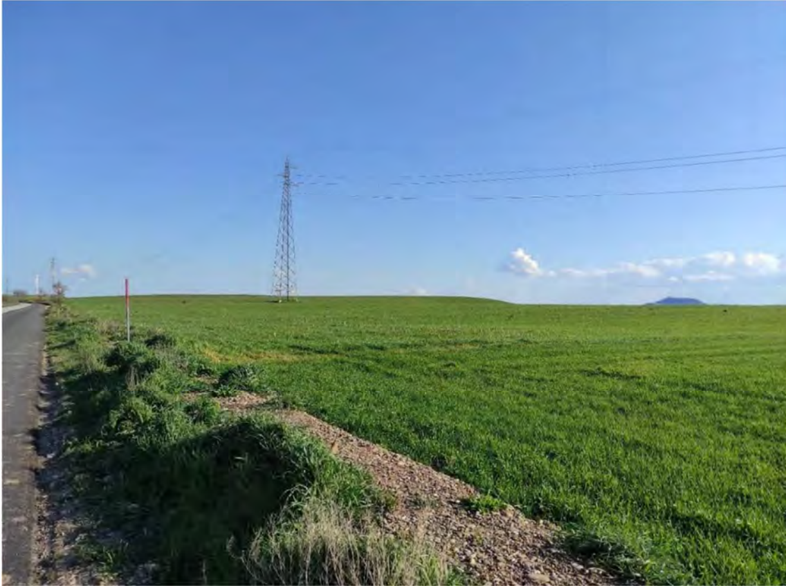
Figura 16 – Area Campo Fotovoltaico n.2A – Vista Lato Nord
