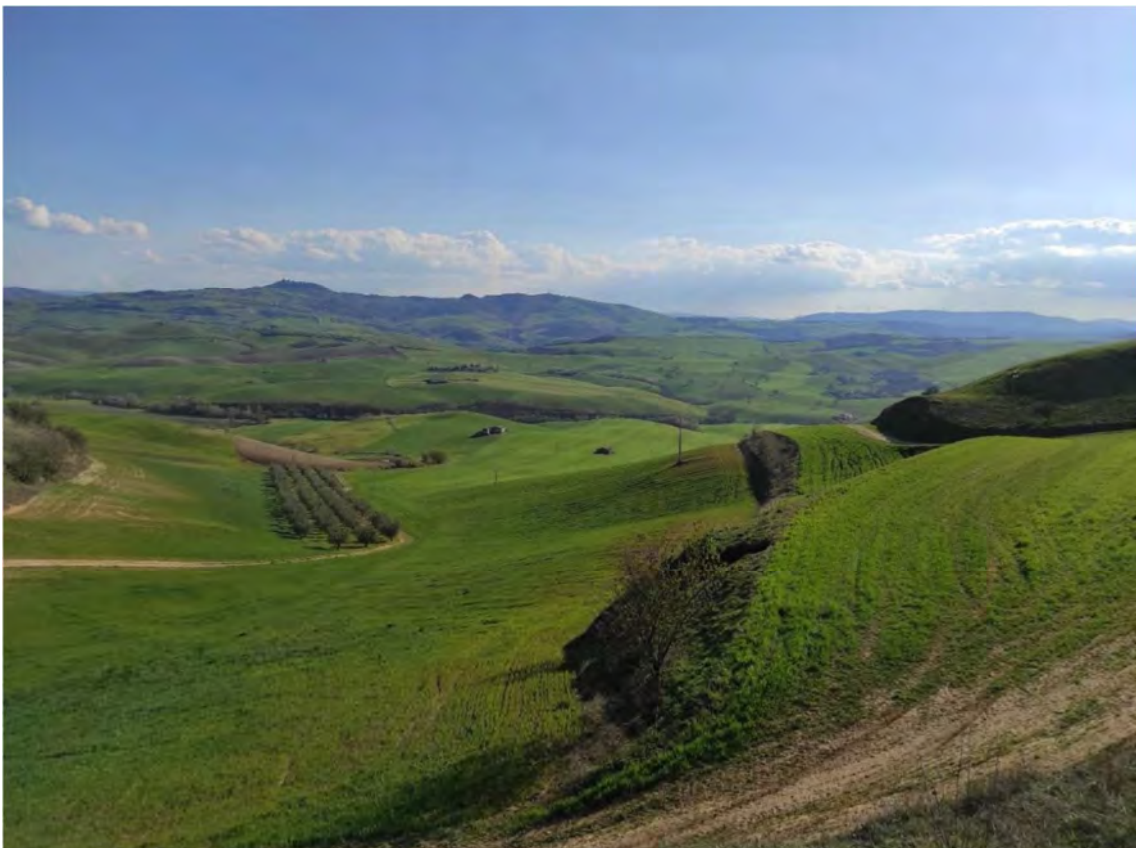
Figura 15 - Area Campo Fotovoltaico n.2C - Vista Lato Nord
