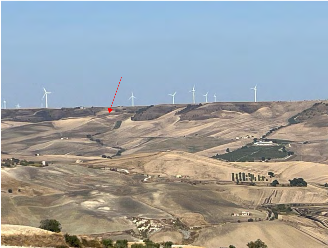
Figura 43 – Foto dalla Strada Provinciale 6 (sotto l'abitato di Acerenza)
