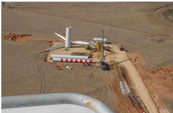
Figura 21 – Piazzola per il montaggio dell'aerogeneratore
