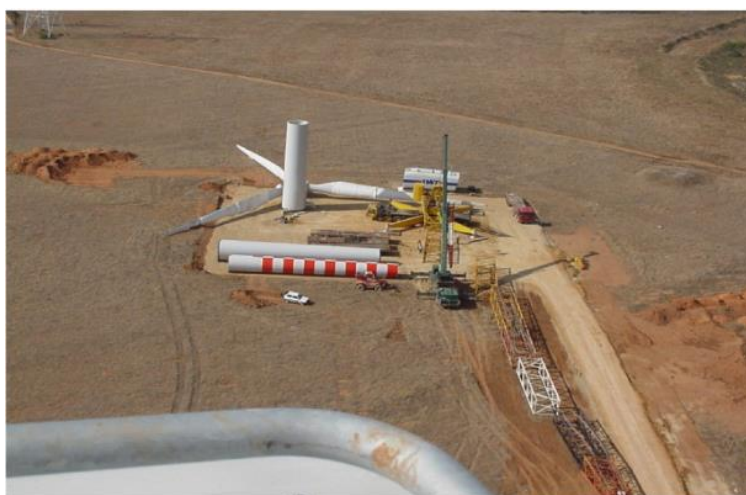
Figura 11 – Piazzola per il montaggio dell'aerogeneratore
