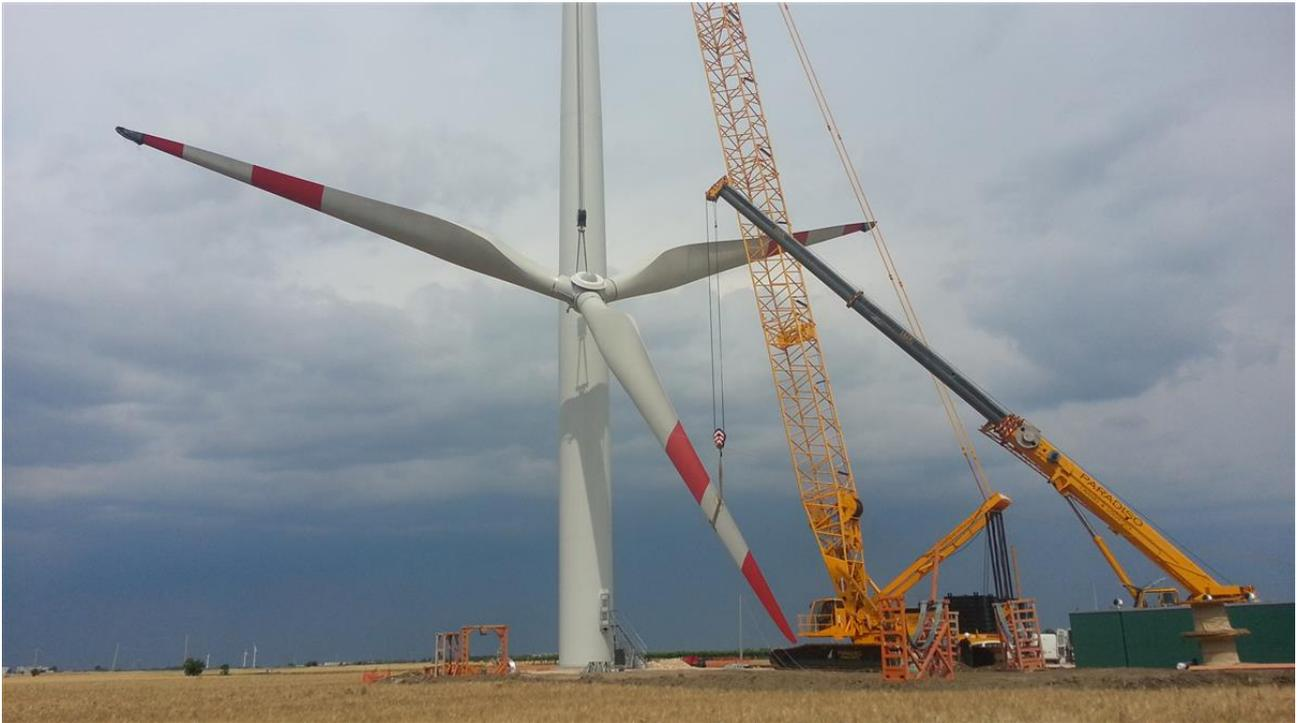
Figura 5 | Operazioni di montaggio aerogeneratori
