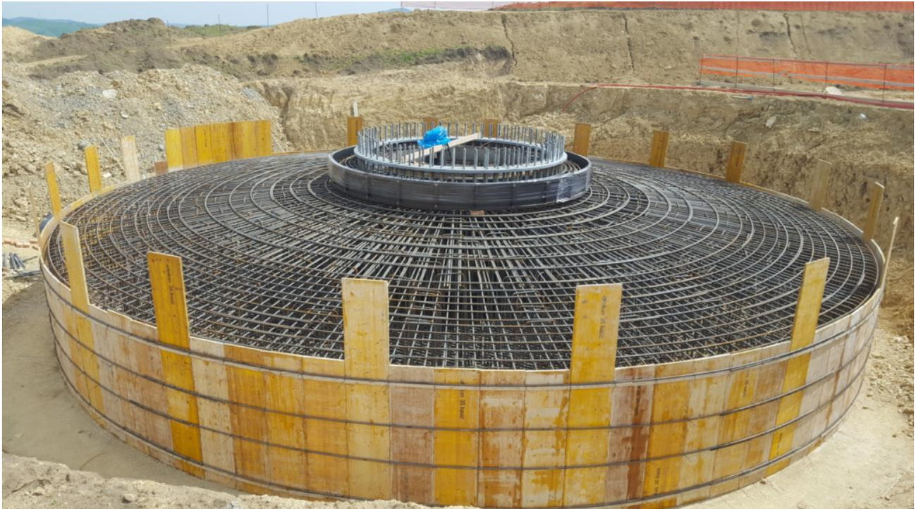
Figura 4 | Strutture di fondazione degli aerogeneratori
