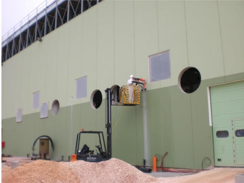
*Figura 8 – Foto di repertorio 1 – Taglio moduli dell'edificio in cui è installato l'impianto BL2*
