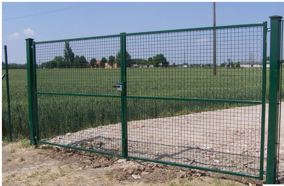
Figura 03- Esempio tipologico cancello della recinzione perimetrale
