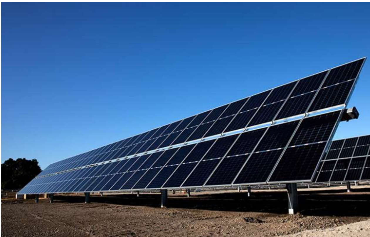
Figura 5-2 – Tipico tracker fotovoltaico in configurazione "2-Portrait"
