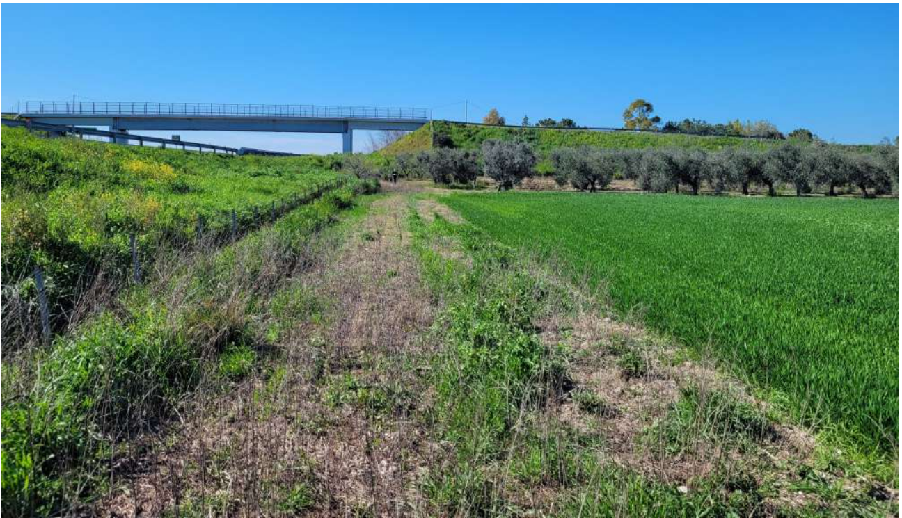
Figura 5 – Vista ripresa campo 3 da sud
