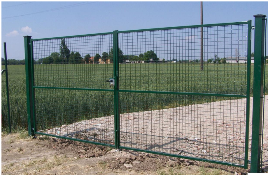
Figura 03- Esempio tipologico cancello della recinzione perimetrale
