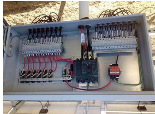
Le operazioni da eseguire sono in questo caso la posa in opera delle staffe ed il fissaggio ad esse del quadro di campo in continua, vengono poi completate alcune iniziali operazioni di cablaggio.
