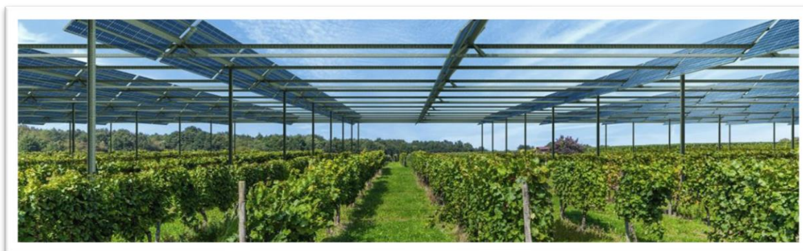
Figura 78. Esempio di Impianto “Agrivoltaico”.
