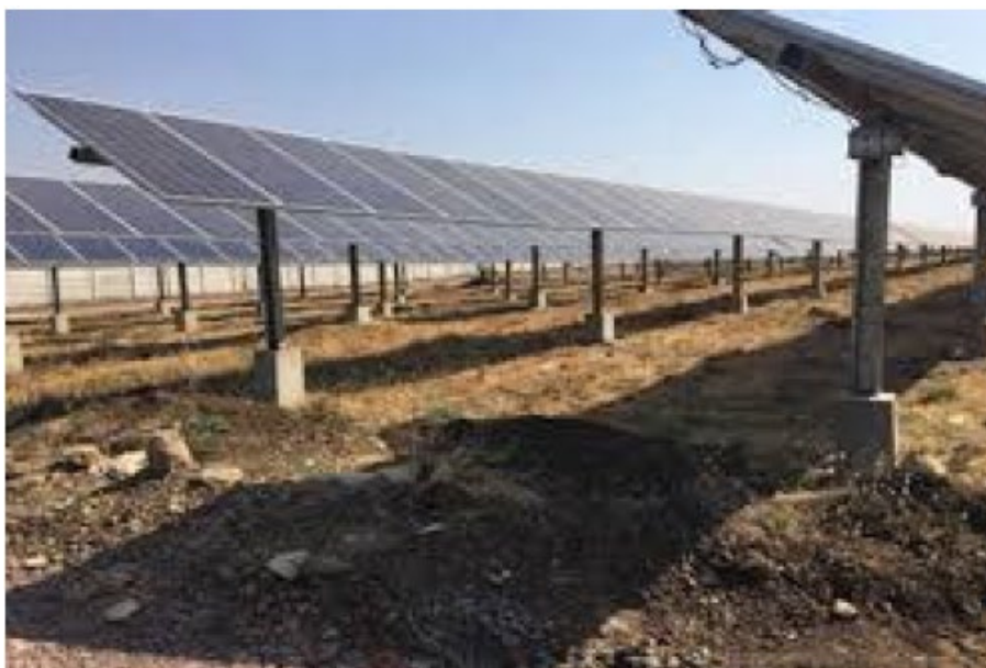
Figura 36. Esempio di impianto fotovoltaico con fondazioni ottenute mediante perforazione del terreno e successiva creazione del palo di fondazione con getto di cemento.
