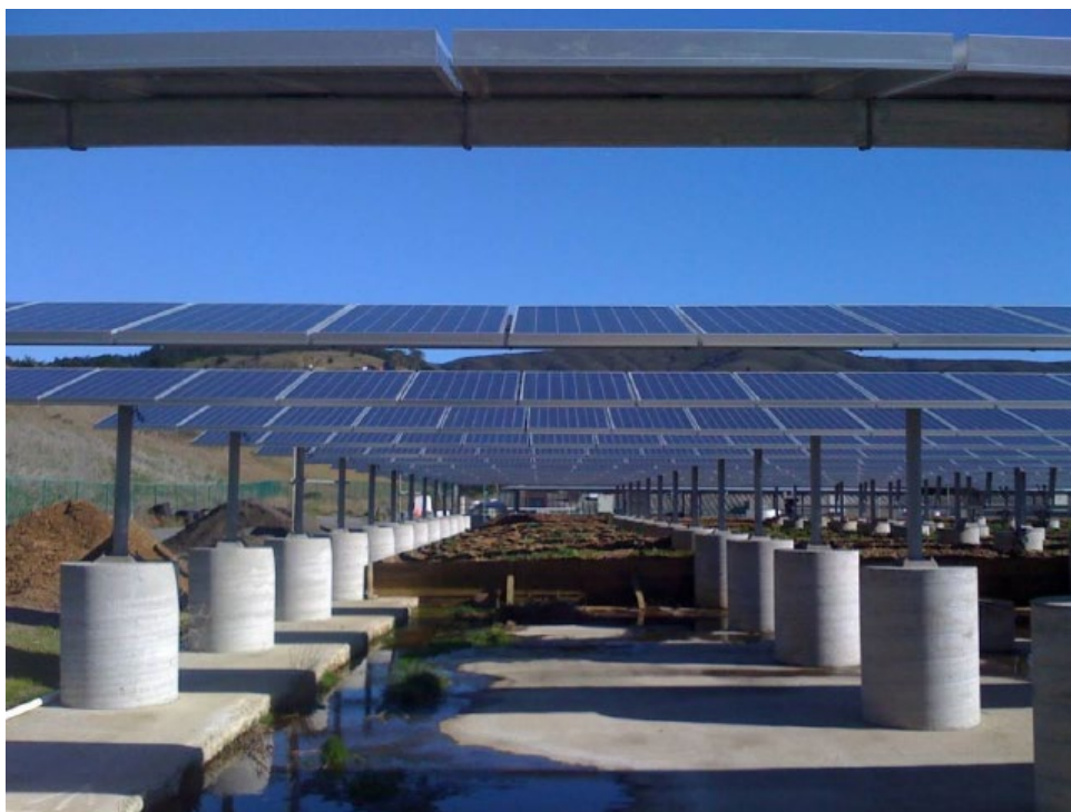
Figura 37. Esempio di impianto fotovoltaico con fondazioni formate da zavorre costituite da plinti in cemento
