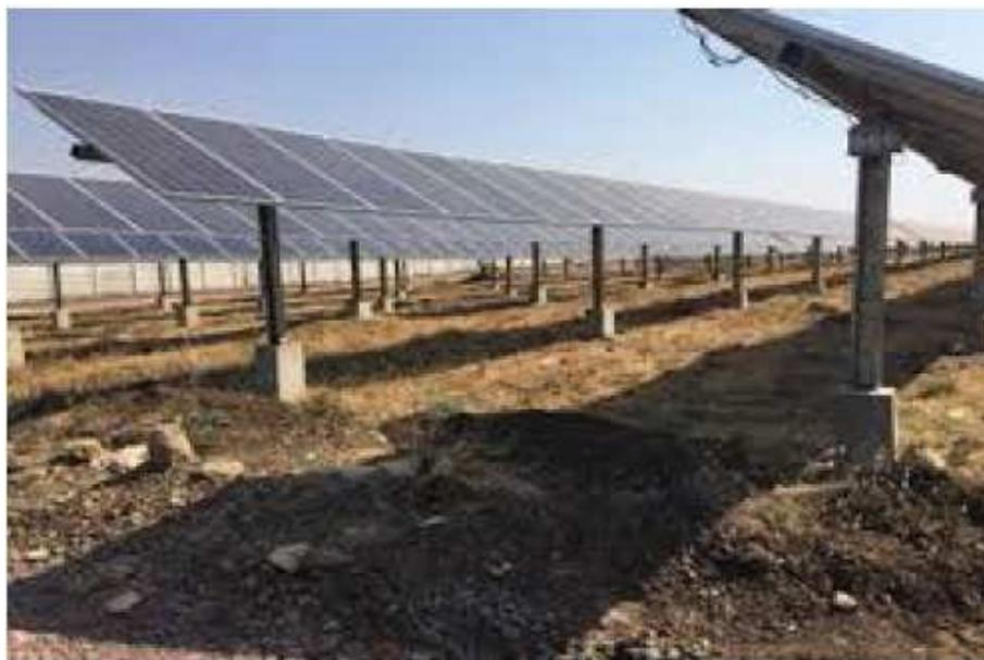
Figura 7. Esempio di impianto fotovoltaico con fondazioni ottenute mediante perforazione del terreno e successiva creazione del palo
