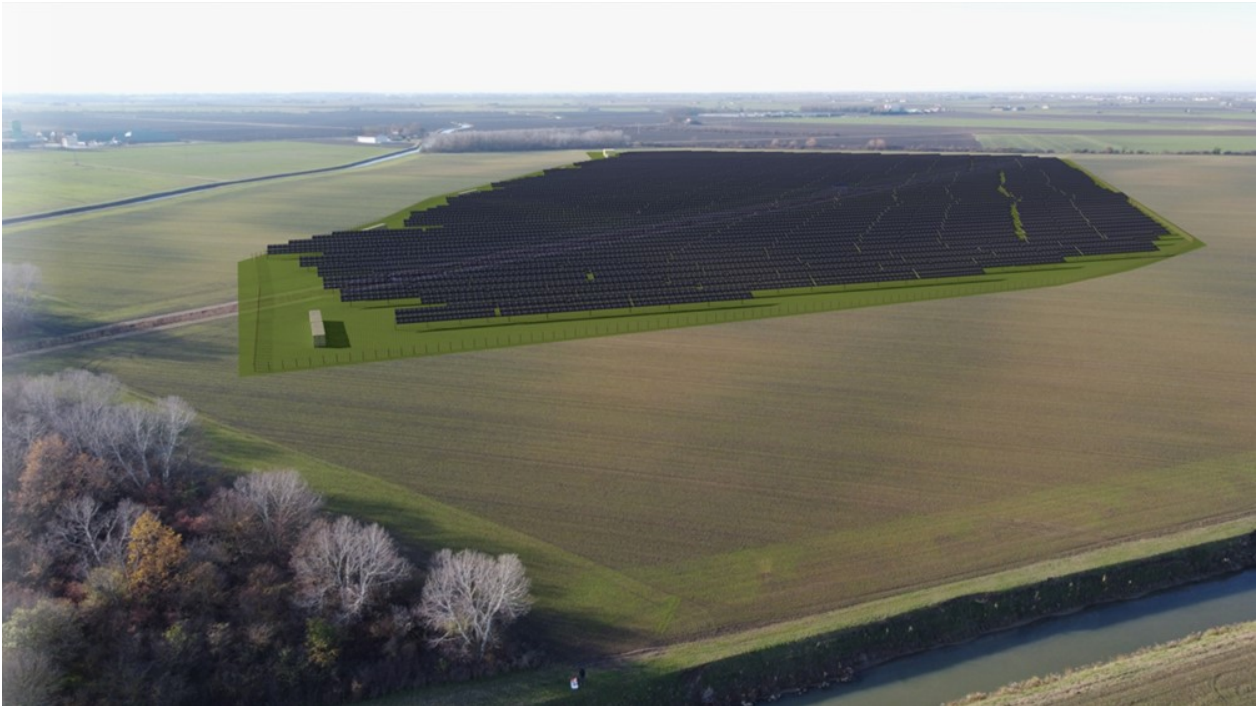
Figura 1. Intervento di mitigazione
