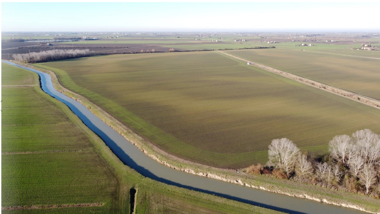
Figura 47 - Punto di osservazione 4 pre-intervento
