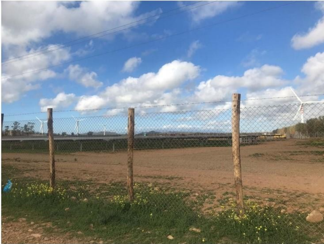
Figura 4 - Esempio di recinzione perimetrale
