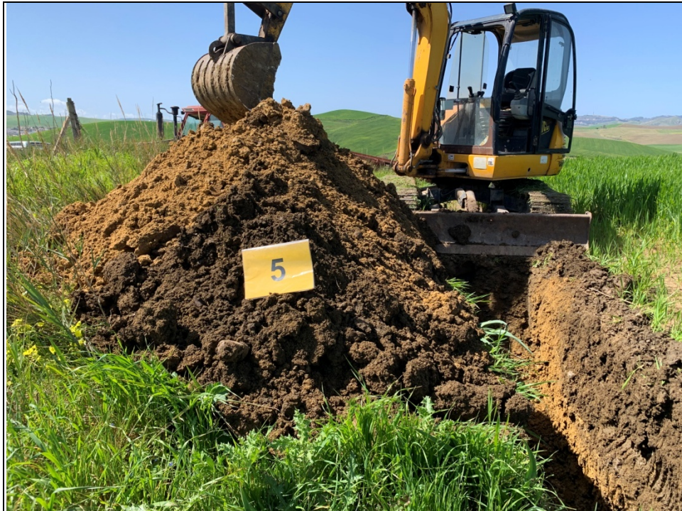
Scavo a pozzo in corrispondenza della Torre 5
