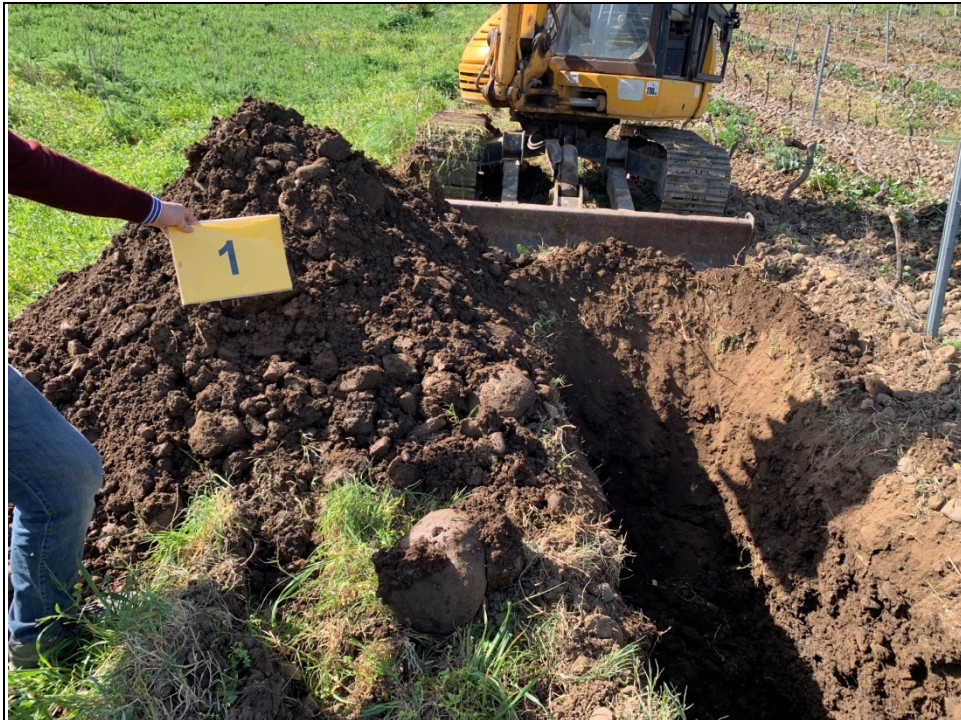
Scavo a pozzo in corrispondenza della Torre 1
