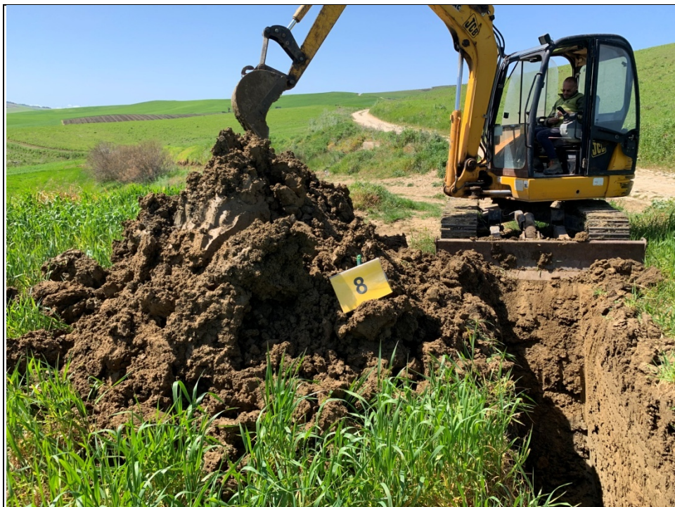
Scavo a pozzo in corrispondenza della Torre 8
