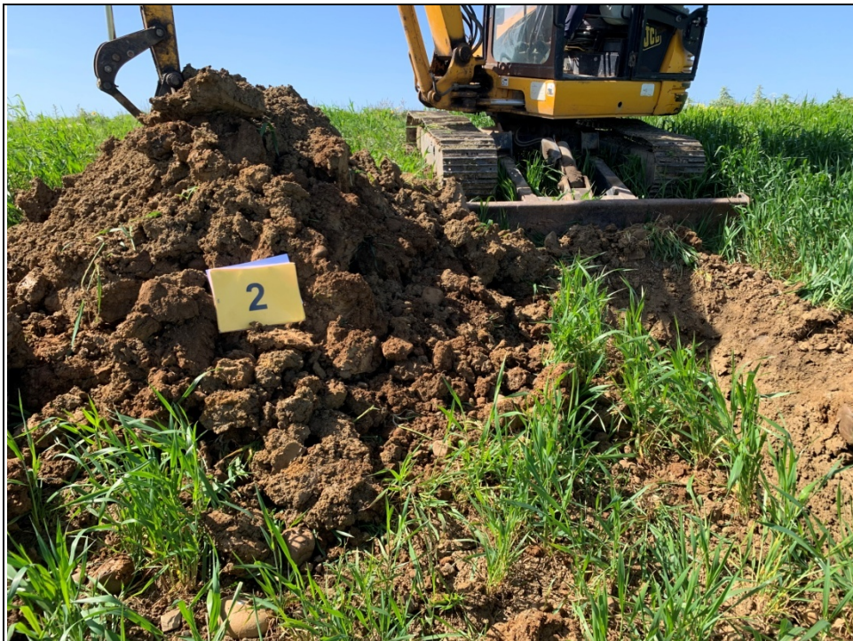
Scavo a pozzo in corrispondenza della Torre 2
