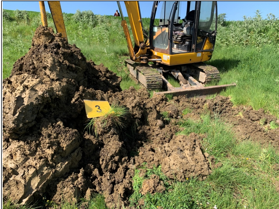
Scavo a pozzo in corrispondenza della Torre 3
