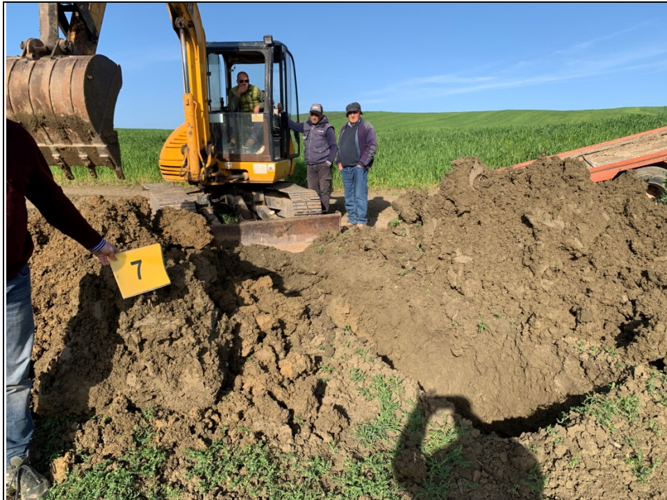
Scavo a pozzo in corrispondenza della Torre 7
