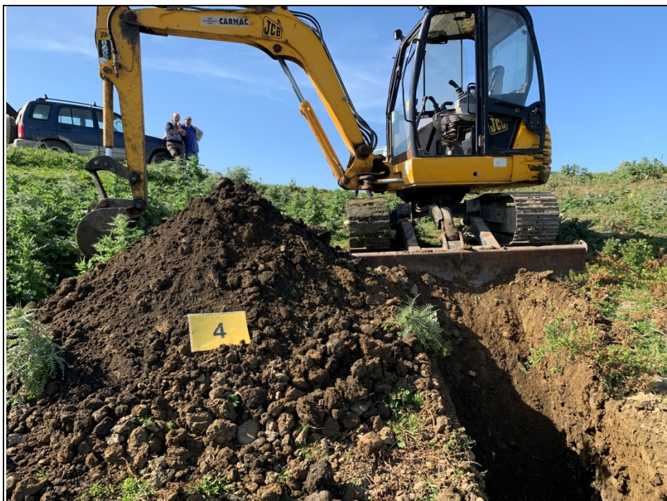
Scavo a pozzo in corrispondenza della Torre 4
