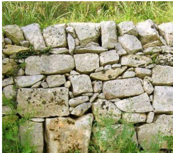
Figura 20 - Tipologie di muri di sostegno: a sx. in cls. con rivestimento in pietrame, a dx. muro a secco
