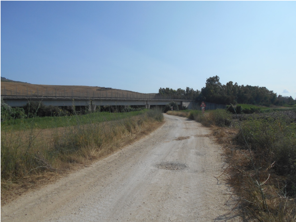
UR9 - R.T. 119 (TERRENOBATTUTO) IN CORRISPONDENZA DEL VIADOTTO AUTOSTRADALE E DEL PASSAGGIO A LIVELLO. VISTA DA NORD VERSO SUD.
