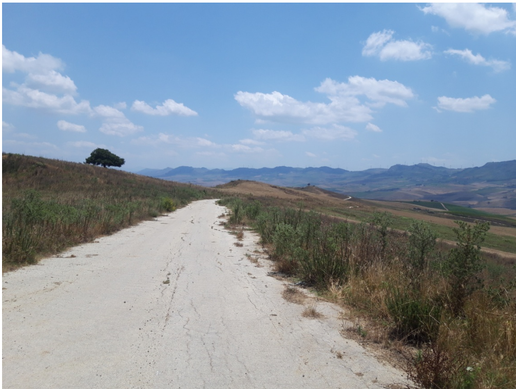
UR9 - SB14 TIPOLOGIA DI STRADAASFALTATA.
