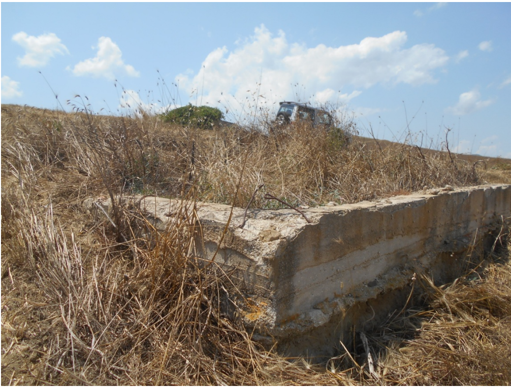
UR6. CAMPO DI GRANO SETTORE CAVIDOTTO. RUDERE IN CLS
