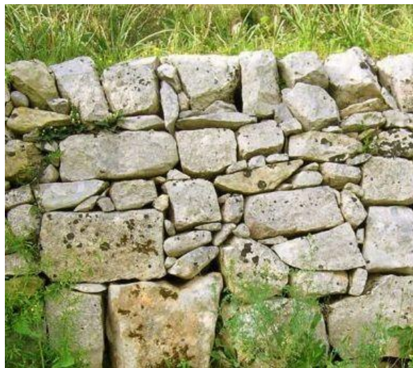
Figura 14 - Tipologie di muri di sostegno: da sinistra in calcestruzzo con rivestimento in pietrame e muro a secco
