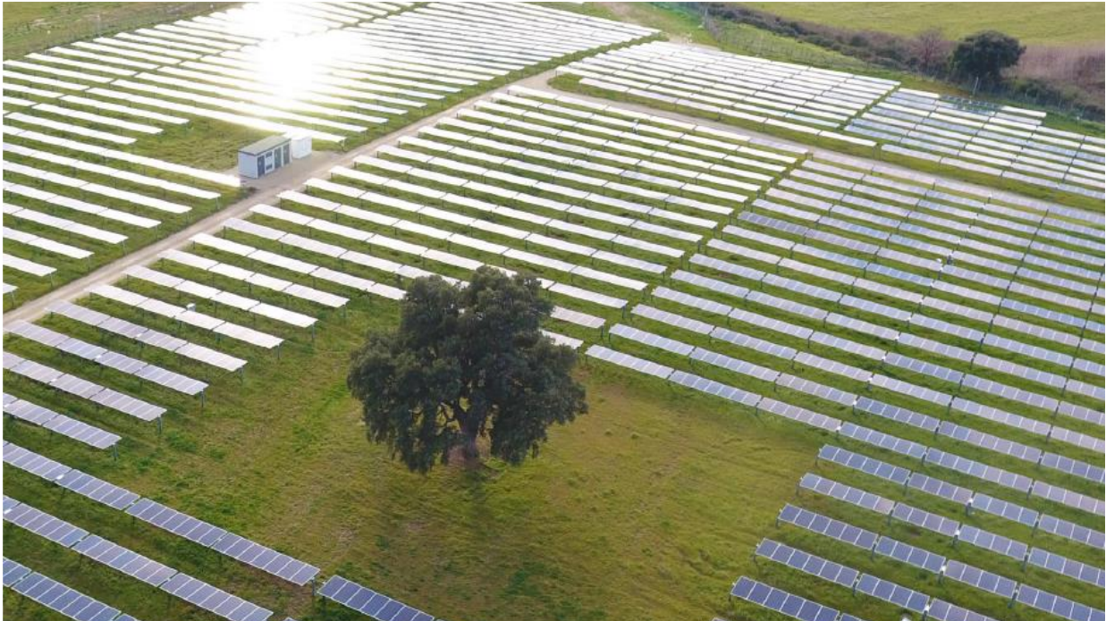
Figura 9 – esempio di impianto realizzato con i tracker proposti e pannelli in configurazione monofilare
