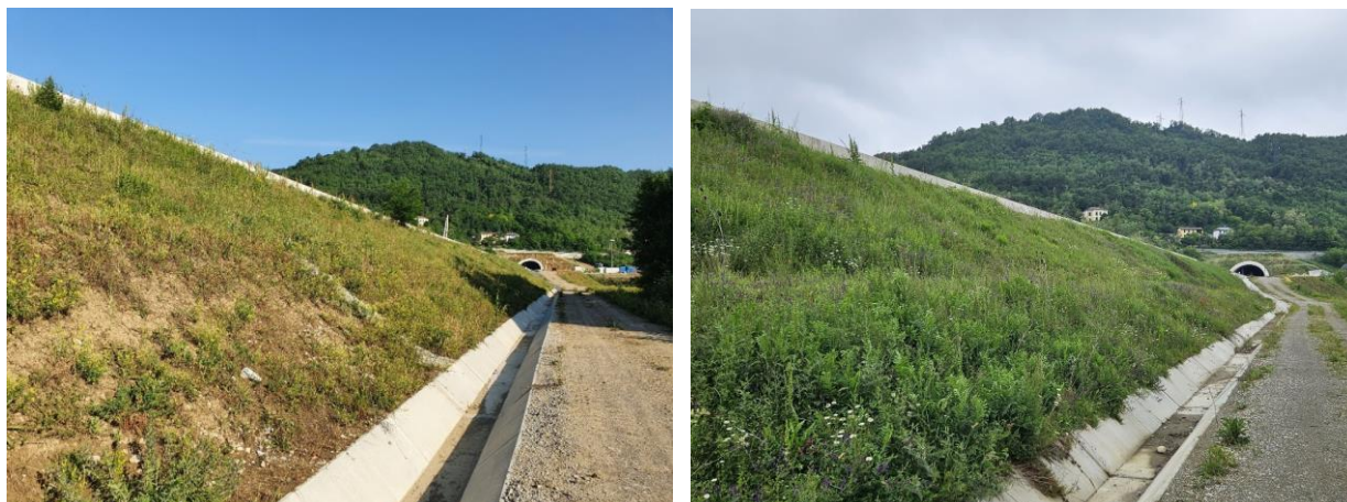
Figura 81: area di cantiere VEG-SS-500D (maggio 2022 sinistra- maggio 2023 destra)
