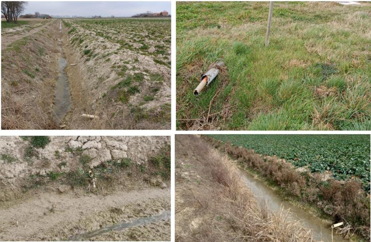
**Figura 7 – Dettaglio di tubazioni interrate di drenaggio esistenti emerse in Sito**
