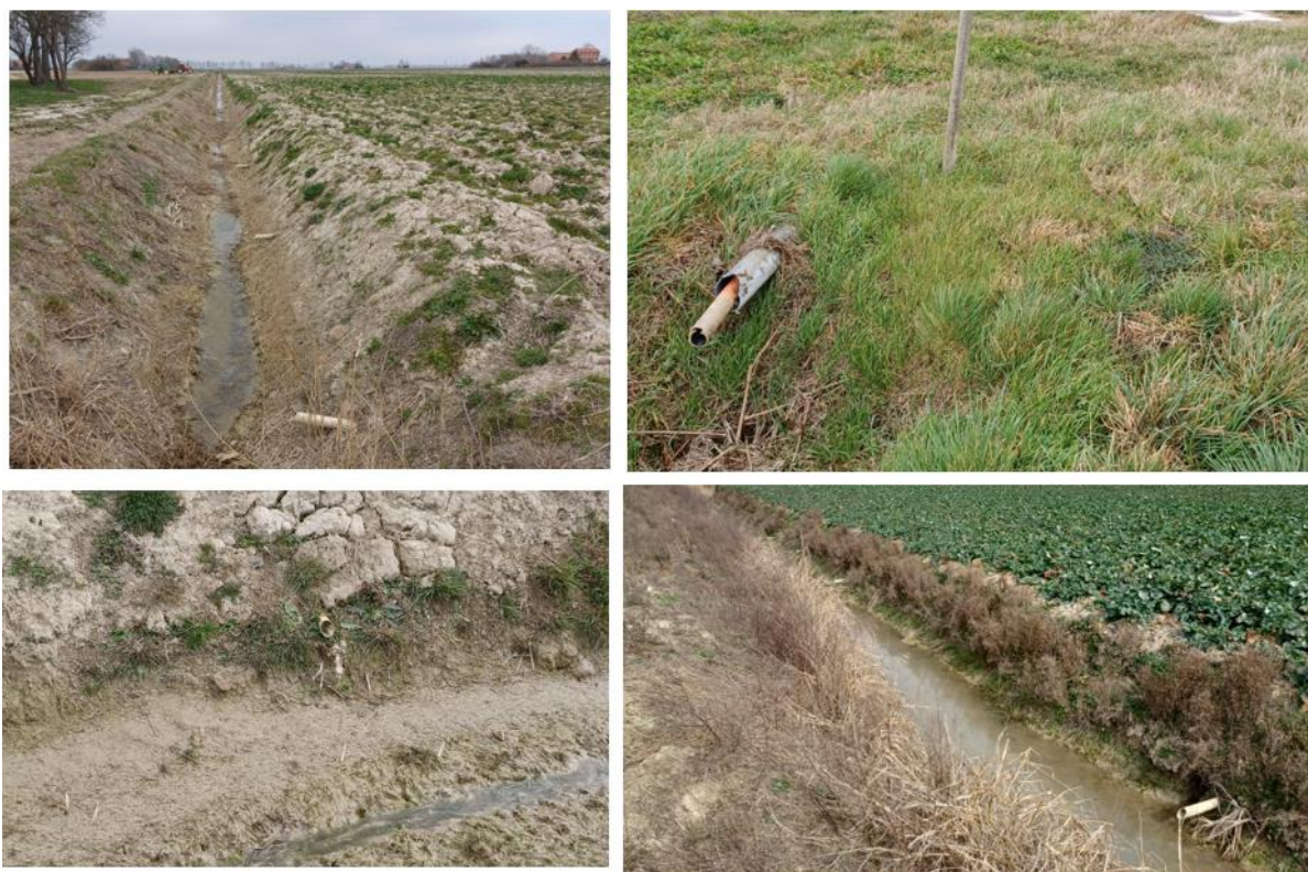
Figura 13 – Dettaglio di tubazioni interrate di drenaggio esistenti emerse in Sito
