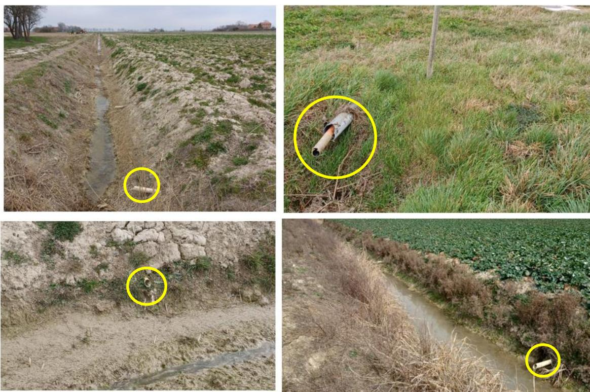
**Figura 4 - Dettaglio di tubazioni interrate di drenaggio esistenti emerse in Sito (in giallo).**
