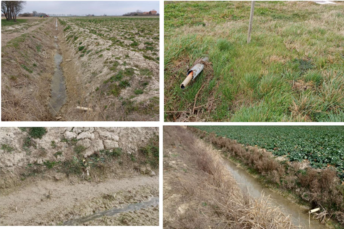
Figura 9 – Dettaglio di tubazioni interrate di drenaggio esistenti emerse in Sito
