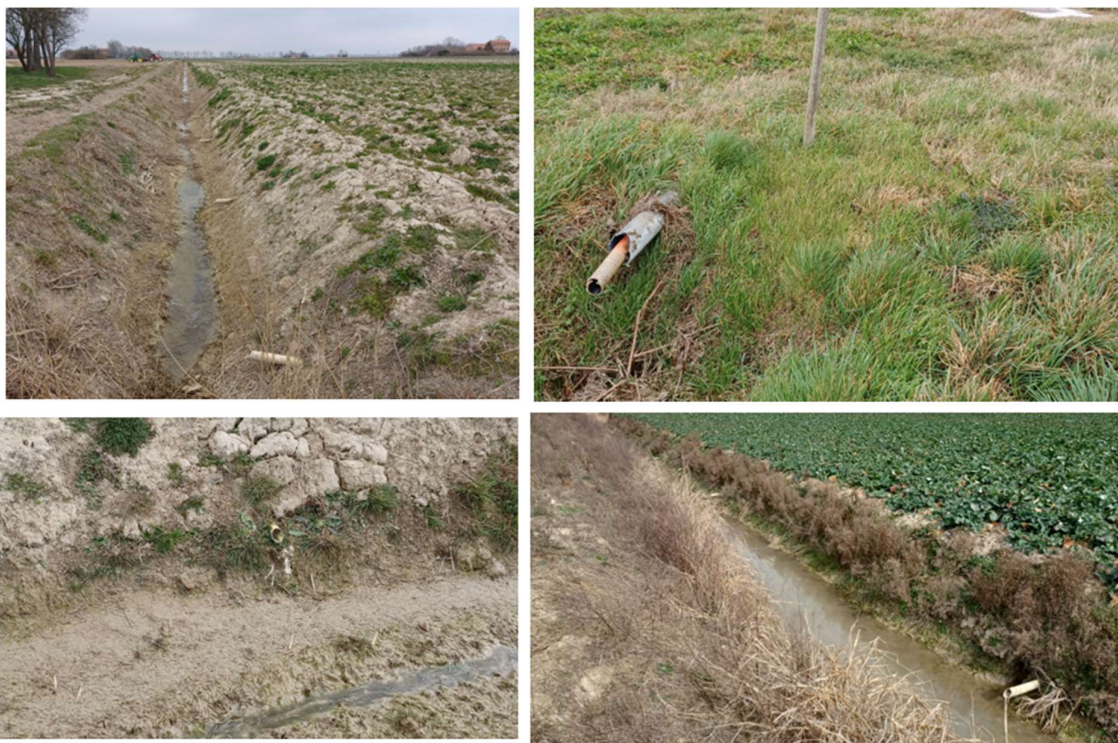
Figura 69 – Dettaglio di tubazioni interrate di drenaggio esistenti emerse in Sito
