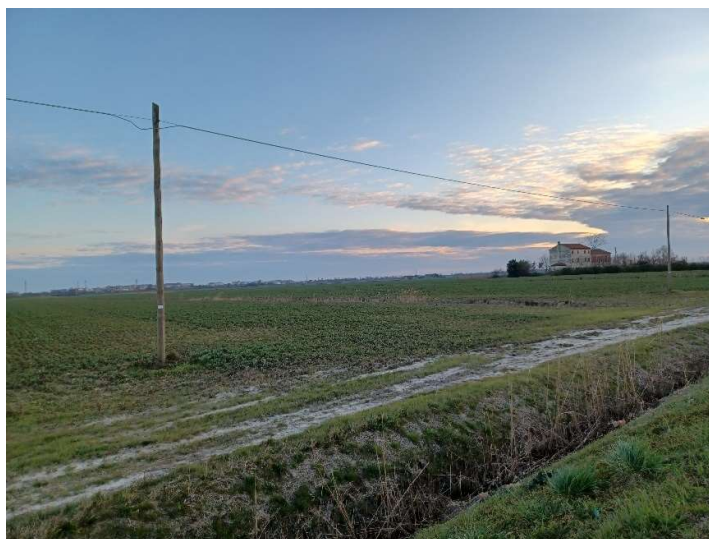
Figura 63 – Foto scattate in sito su linee elettriche presenti
