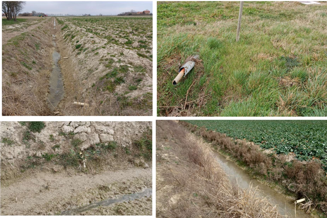
Figura 16 – Dettaglio di tubazioni interrante di drenaggio esistenti emerse in Sito
