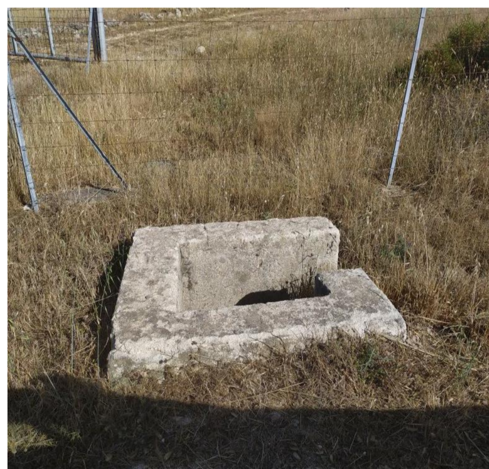
Interferenza I14. Fotografia sopralluogo BFP di attraversamento idraulico
