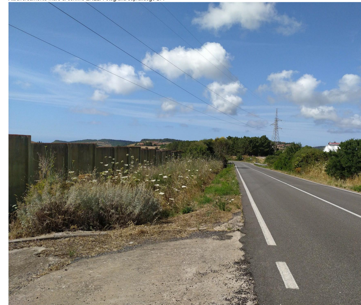
Interferenza I07 Attraversamento muro di confine ENEL. Fotografia sopralluogo BFP
