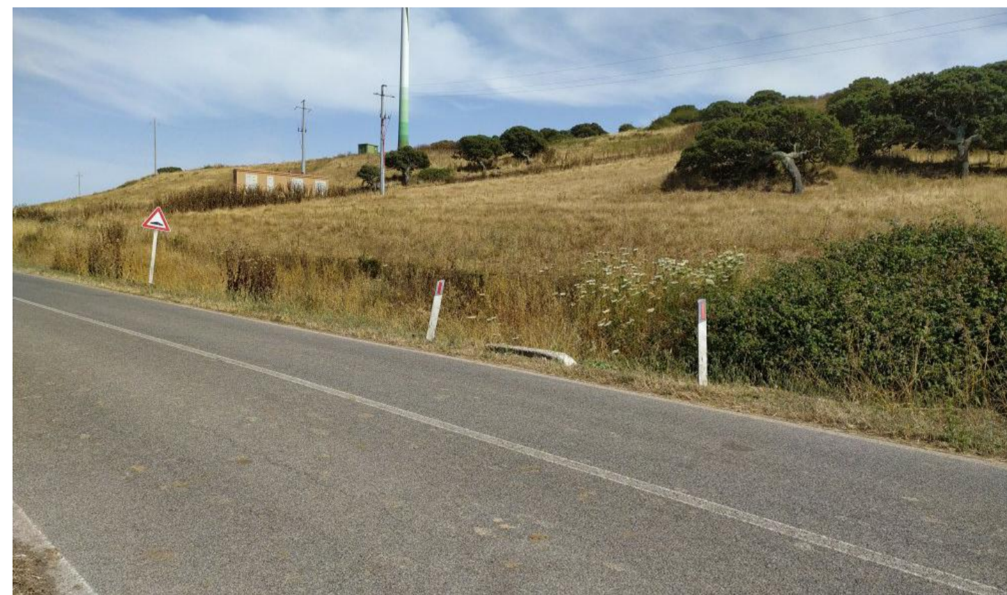
Interferenza 109. Fotografia da sopralluogo di attraversamento idraulico
