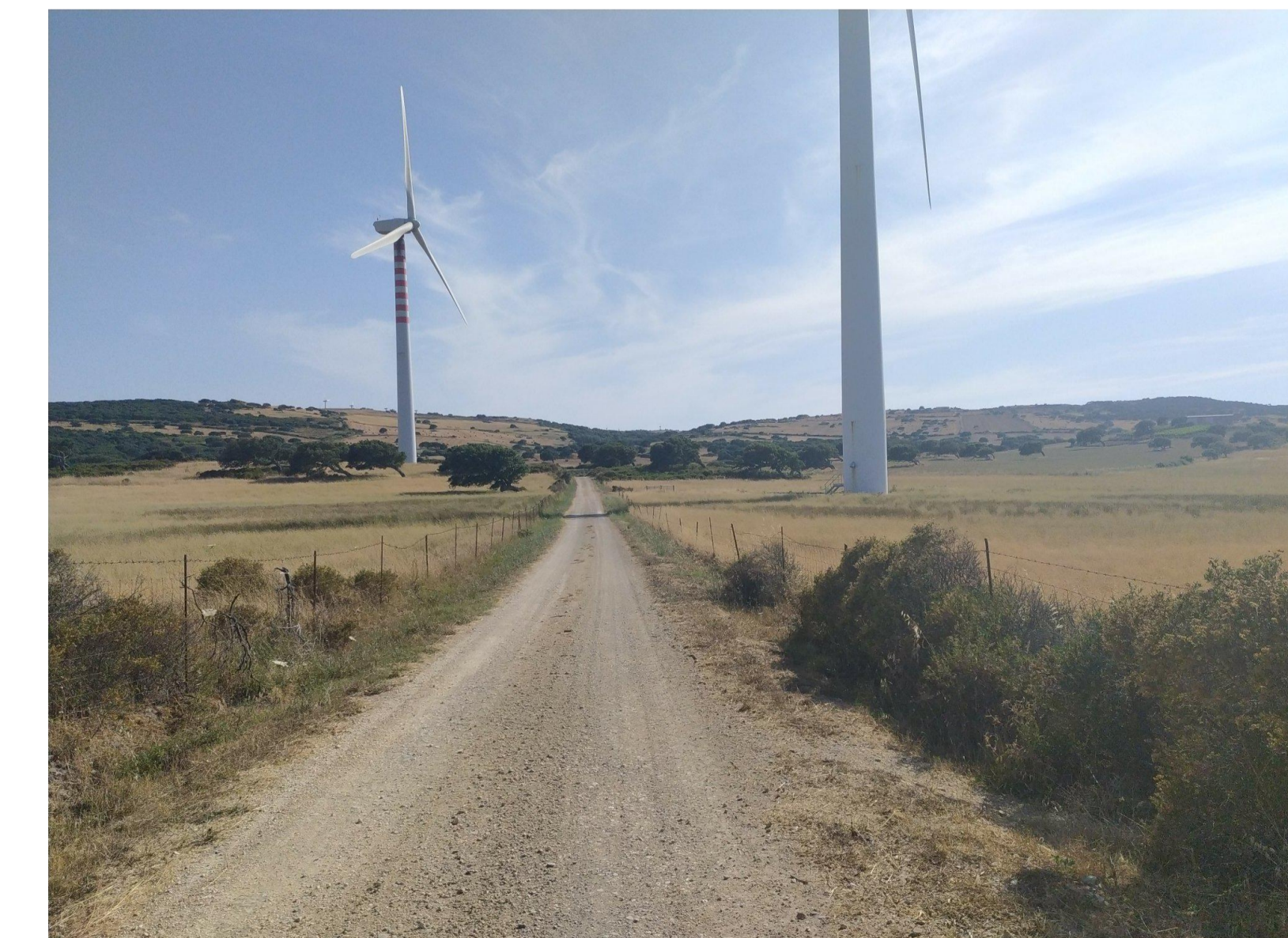
Fotografia sopralluogo BFP su Strada vicinale di San Bachisio
