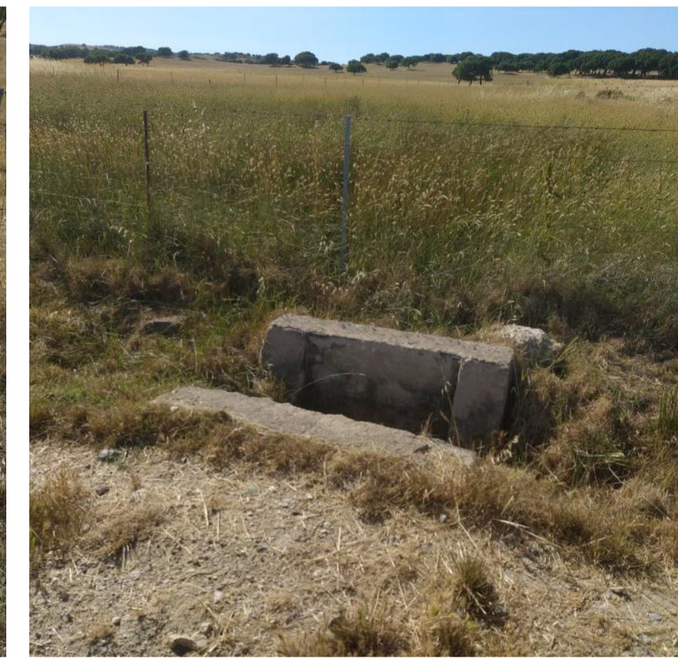
Interferenza 112. Fotografia sopralluogo BFP di attraversamento idraulico
