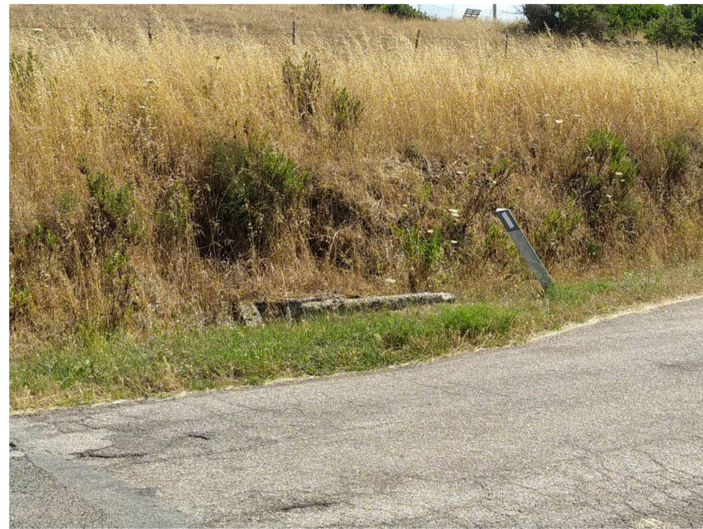
Interferenza 108. Fotografia da sopralluogo di attraversamento idraulico
