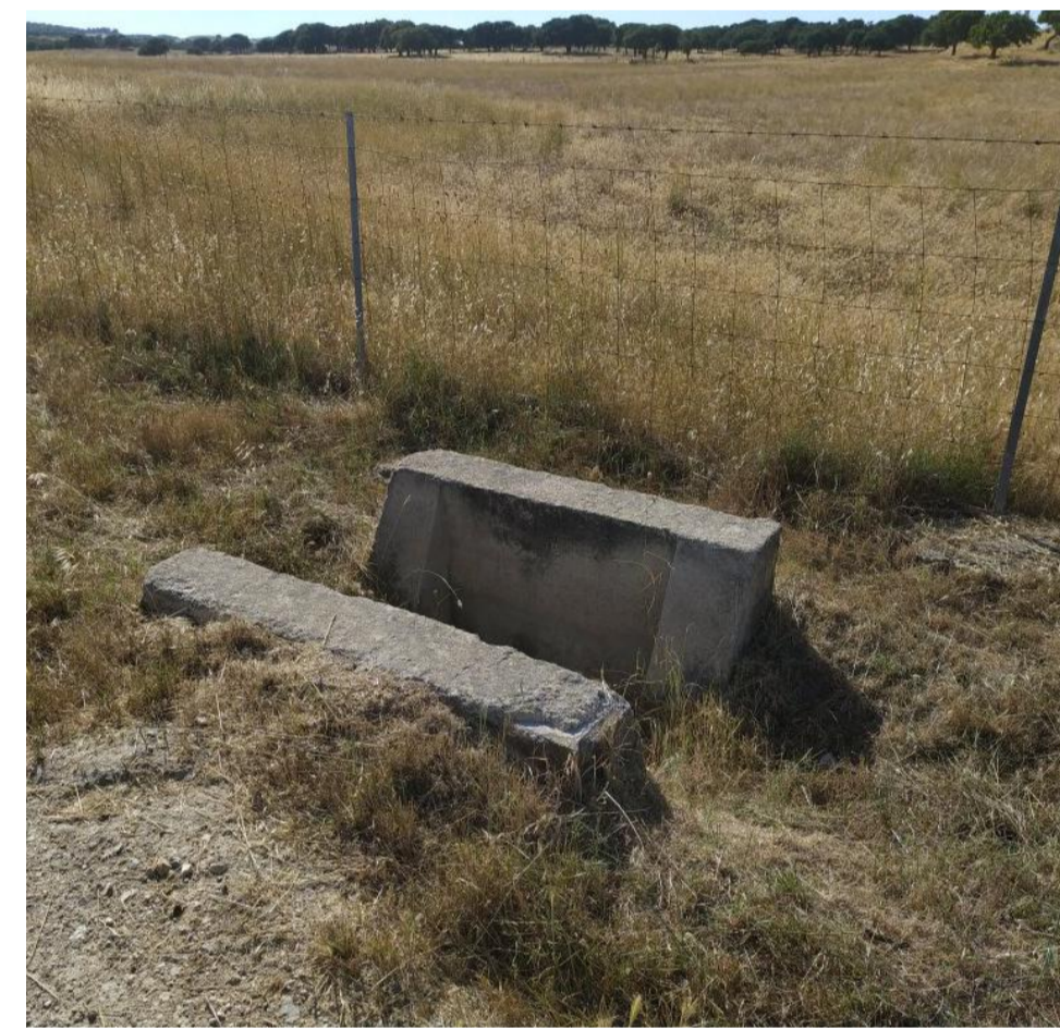
Interferenza 111. Fotografia sopralluogo BFP di attraversamento idraulico
