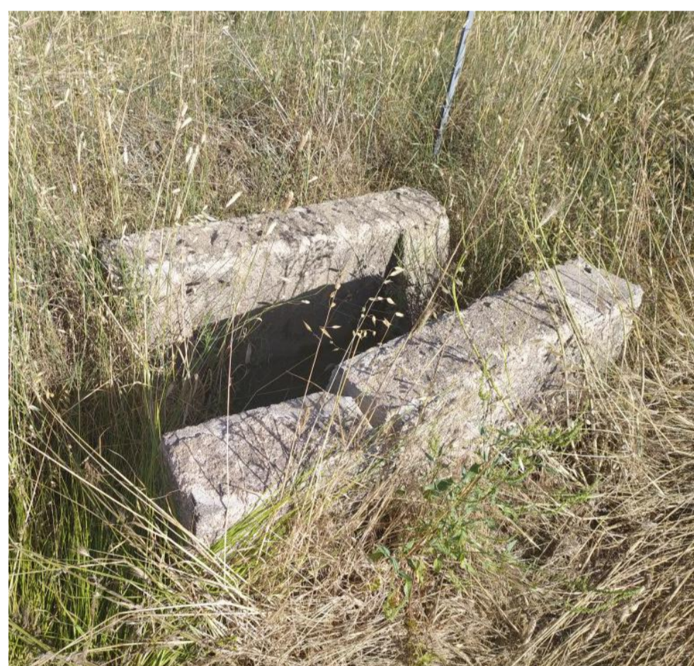
Interferenza I15. Fotografia sopralluogo BFP di attraversamento idraulico
