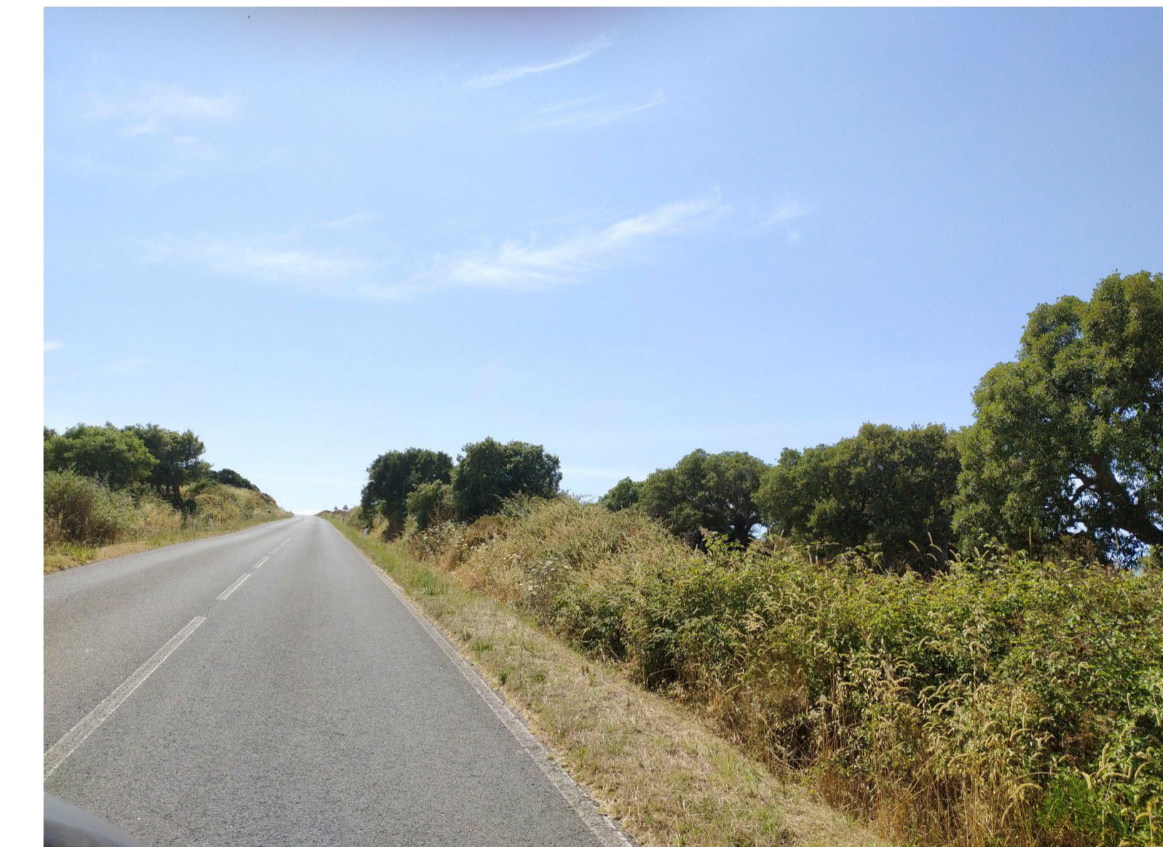
Fotografia sopralluogo BFP su Strada Comunale tra Nulvi e Sedini
