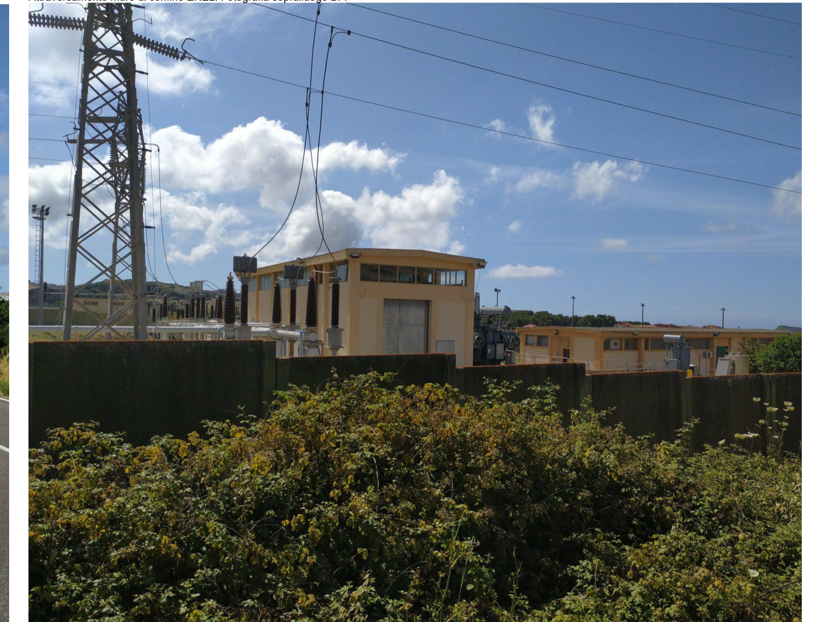
Interferenza I07 Attraversamento muro di confine ENEL. Fotografia sopralluogo BFP
