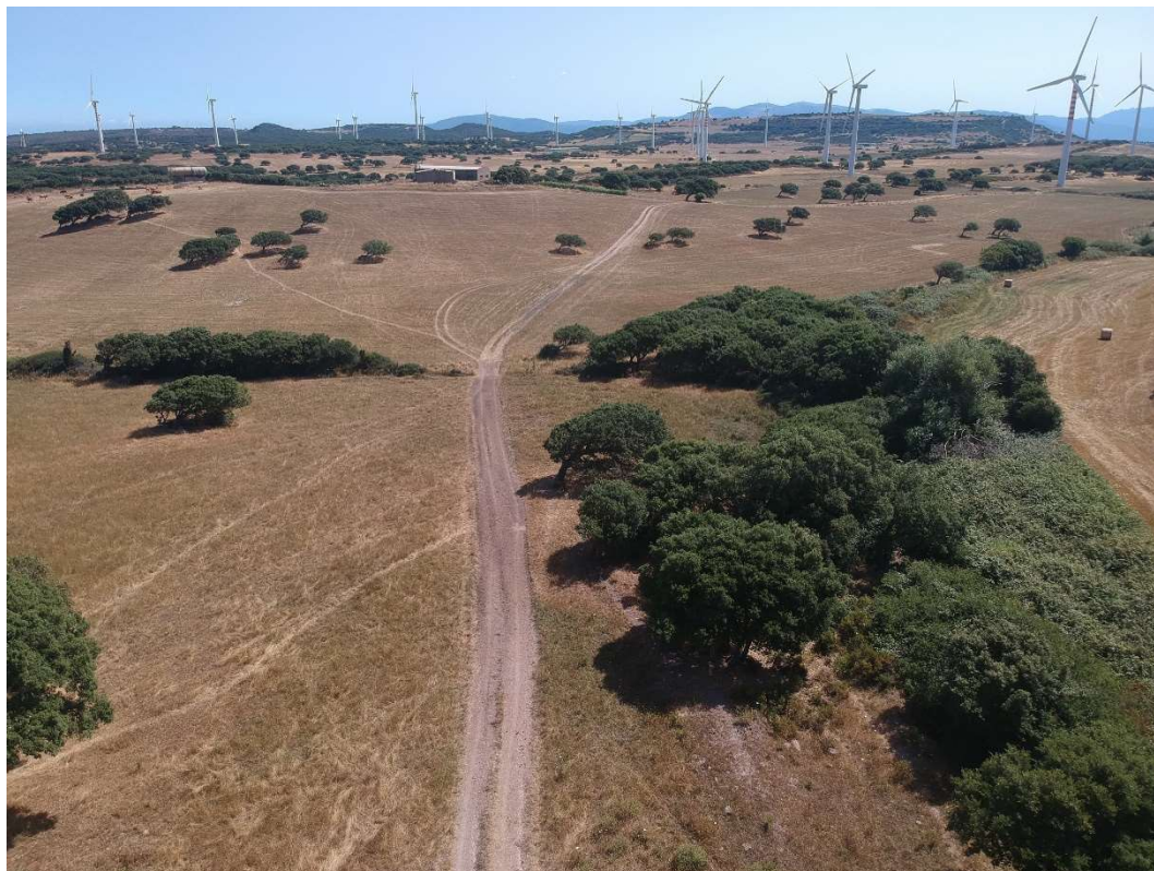
Foto 5 – Scatto dall'alto con drone verso l'area di impianto a ovest
