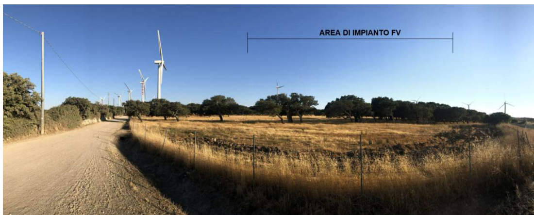
Figura 21 – Punto di vista E _ post-operam
