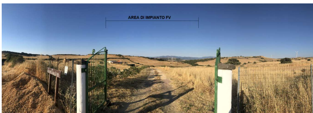
Figura 85 – Punto di vista B _ post-operam
