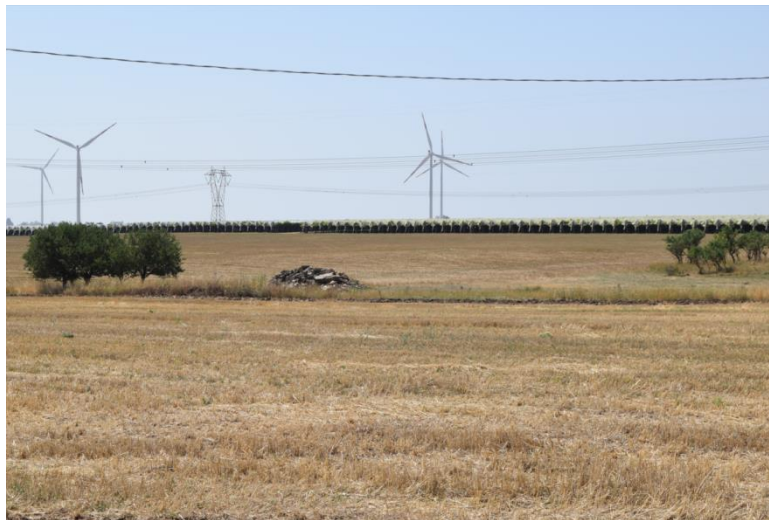
Area d'impianto con in lontananza vigneto ad uva da tavola sotto copertura di film plastico
