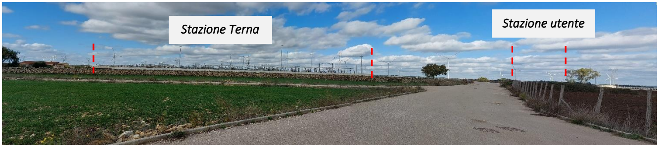
Stazione Elettrica Terna e Stazione Utente
