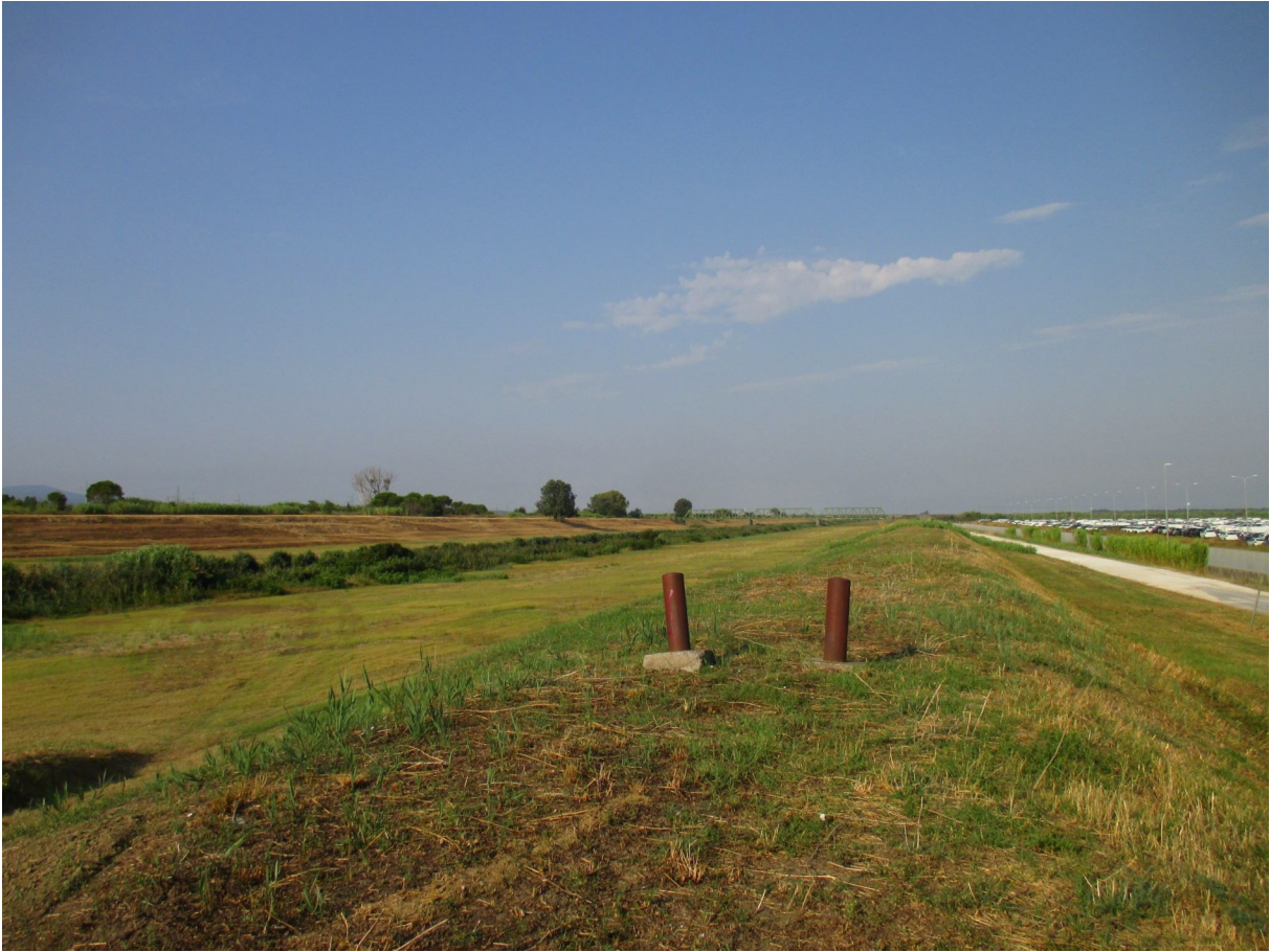
Scolmatore dell'Arno posto a Sud del piazzale auto.
