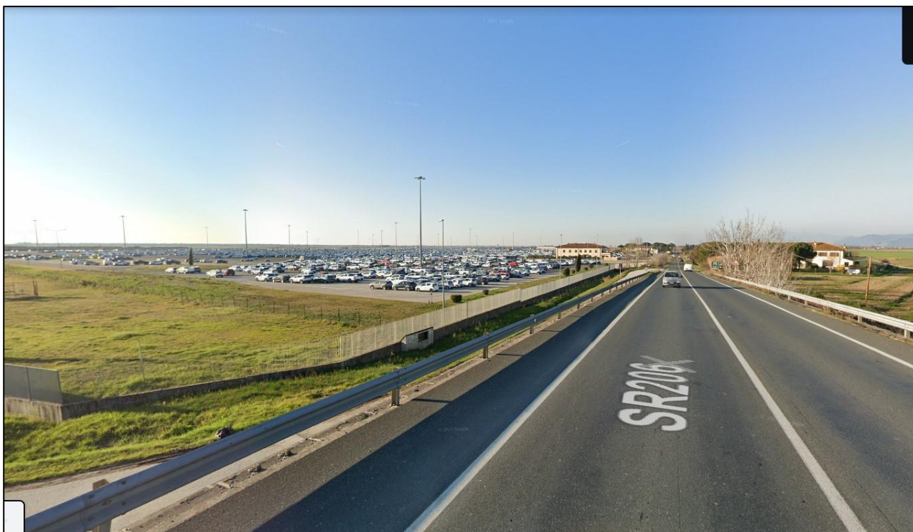
Vista 15 dal ponte sullo Scolmatore Fiume Arno - SR206 ANTE OPERAM
