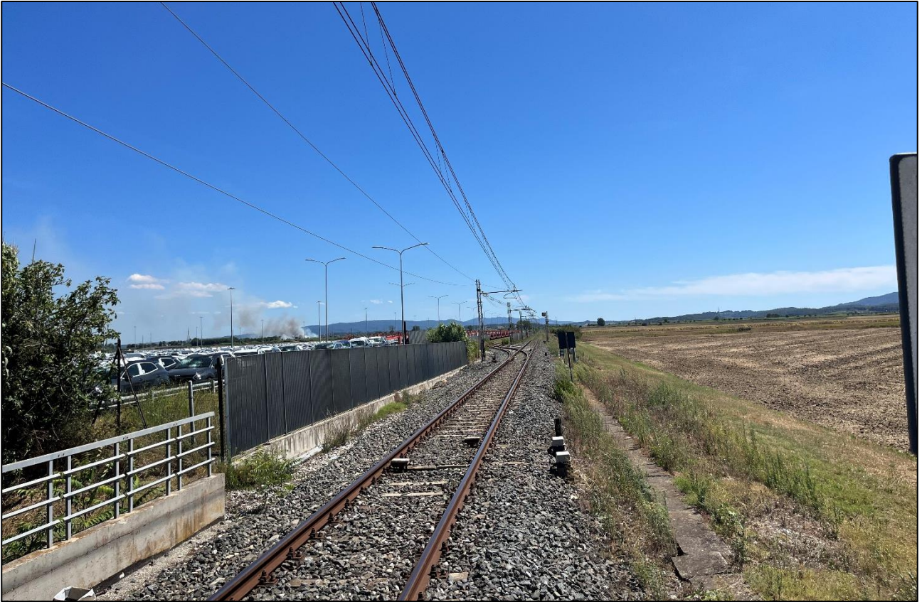
Vista 11 punto di vista a nord-ovest al confine con la ferrovia, inquadramento Autoparco lato ferrovia
