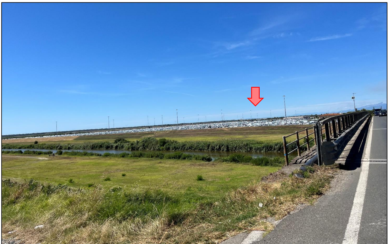
Vista 7 inquadramento dell'area di intervento da un punto di vista a sud-est del lotto, sul ponte che passa sullo Scolmatore del Fiume Arno, proseguendo in auto dalla Frazione Vicarello in direzione Ospedaletto (primo punto da cui è visibile l'Autoparco)
