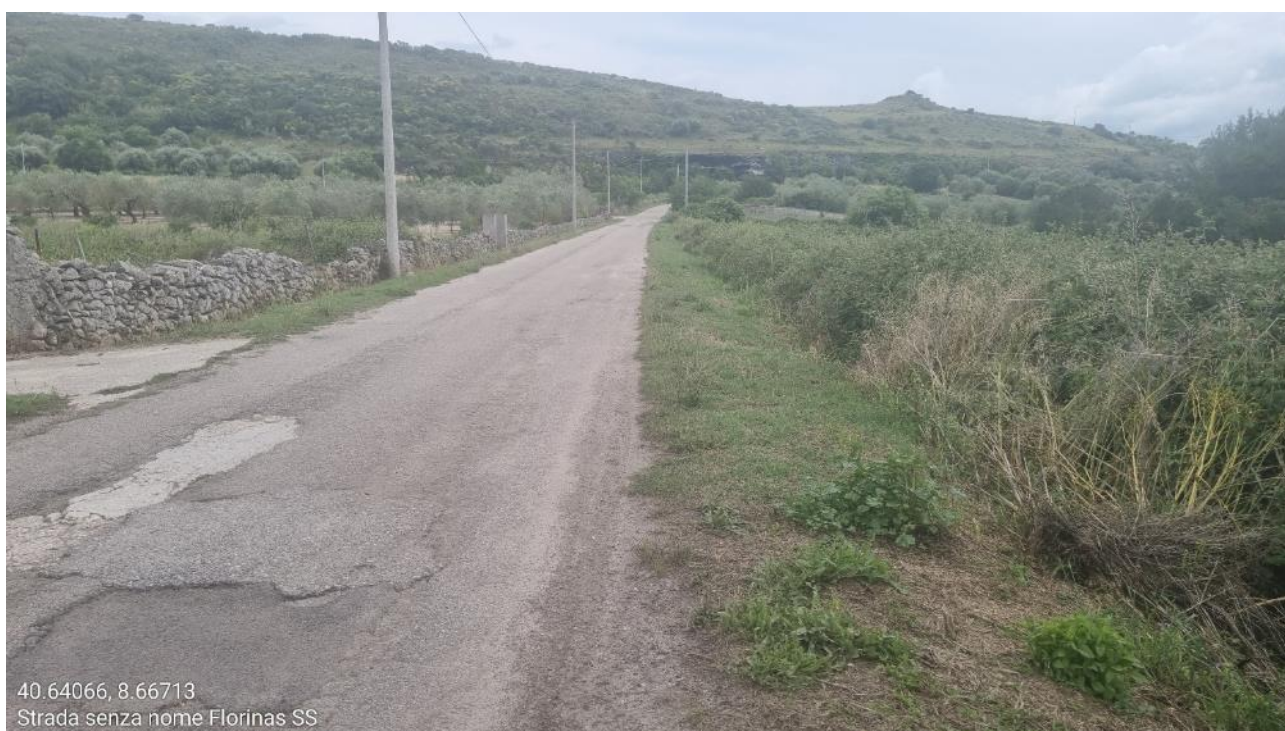
Figura 14.4 - Florinas, loc. a est di S'Abba Iara: percorso del tracciato in progetto su strada asfaltata.
