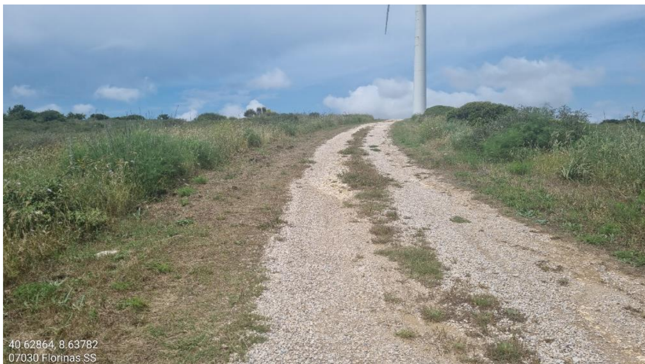
Figura 10.3 - Florinas: aree sgombre di vegetazione in corrispondenza della viabilità interna al parco eolico.
