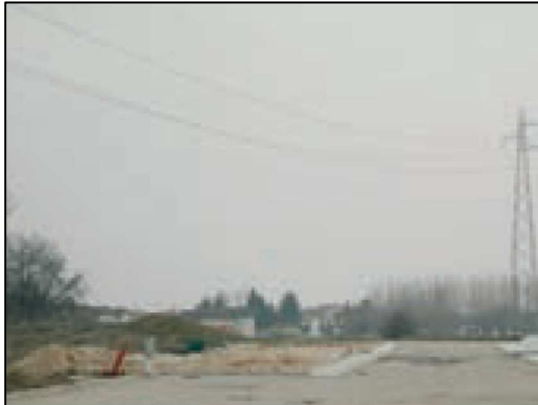
Situazione pericolosa per presenza di linee elettriche aeree in tensione non protette
