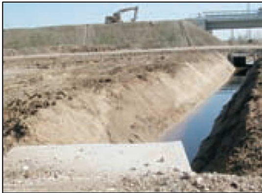
Situazione regolare: il fronte dello scavo è inclinato correttamente
