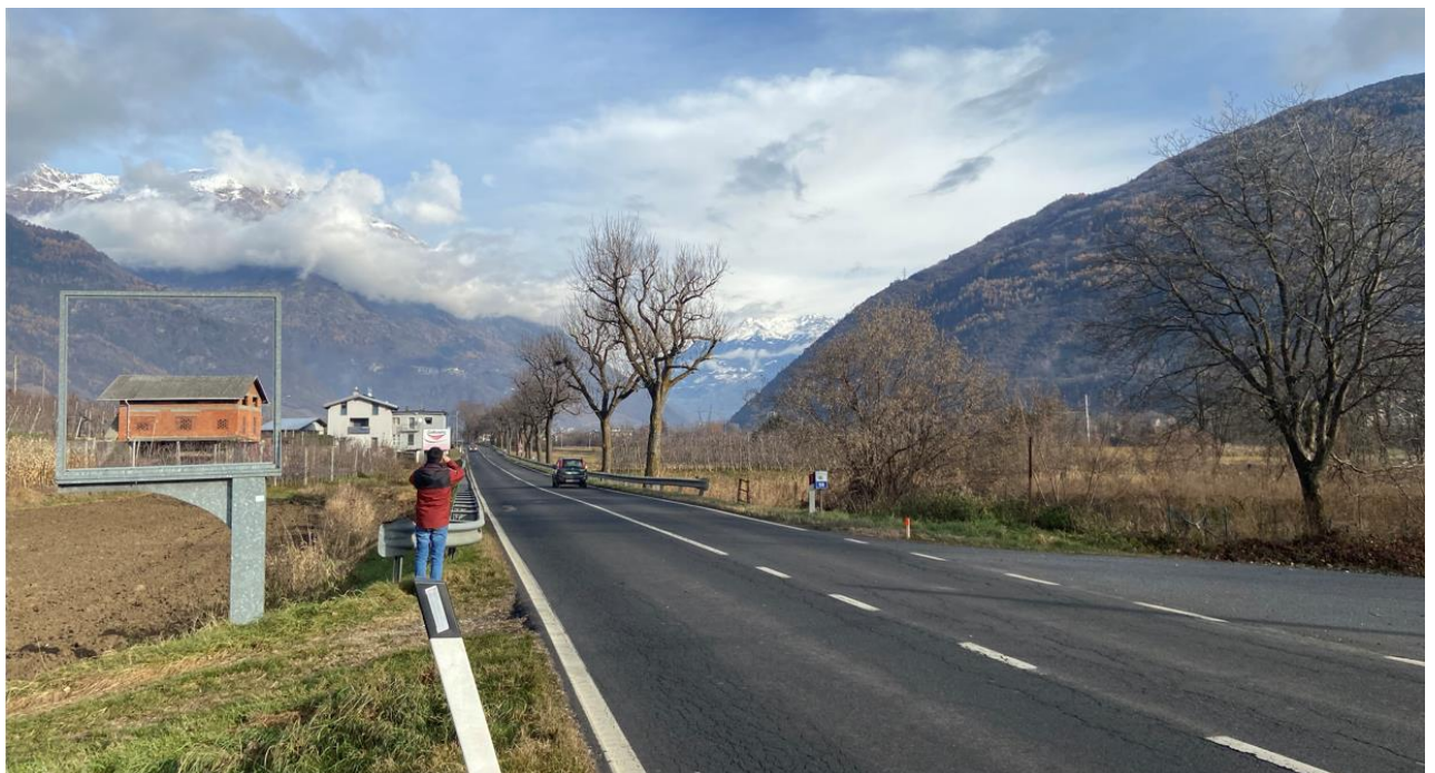
FOTO 6: tratta 4: Vista della SS38 direzione Tirano (vista 3 - Tratta 4).
