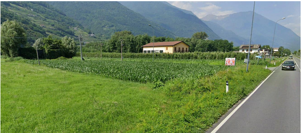
FOTO 4: tratta 3 - Vista della SS38 direzione Tirano dove è prevista l'intersezione T3-II.
