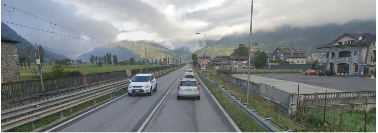
FOTO 12 – Tratta 1: Vista della SS38 direzione Colico. Sulla destra è prevista la viabilità secondaria VS04.
