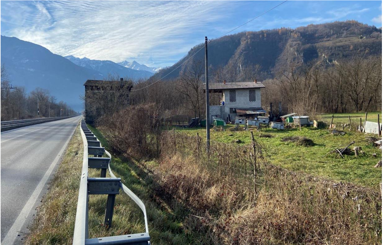
FOTO 7: tratta 3 - Vista della SS38 direzione Colico. In questo tratto è previsto l'adeguamento con sezione Tipo A per inserimento della banchina laterale. In lontananza l'edificio interferente da espropriare.
