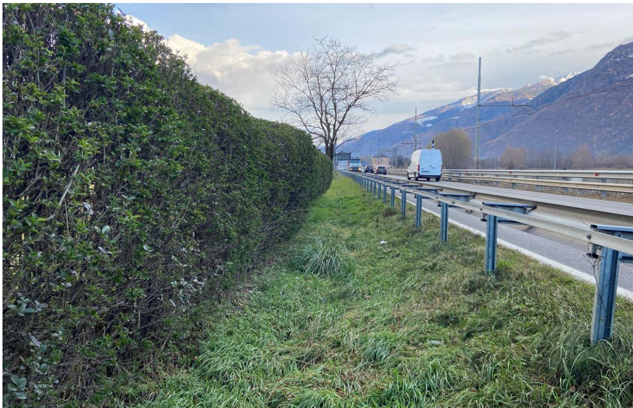
FOTO 14: Vista della SS38 direzione Tirano. In questo tratto è previsto l'adeguamento con sezione Tipo A per inserimento della banchina laterale.
