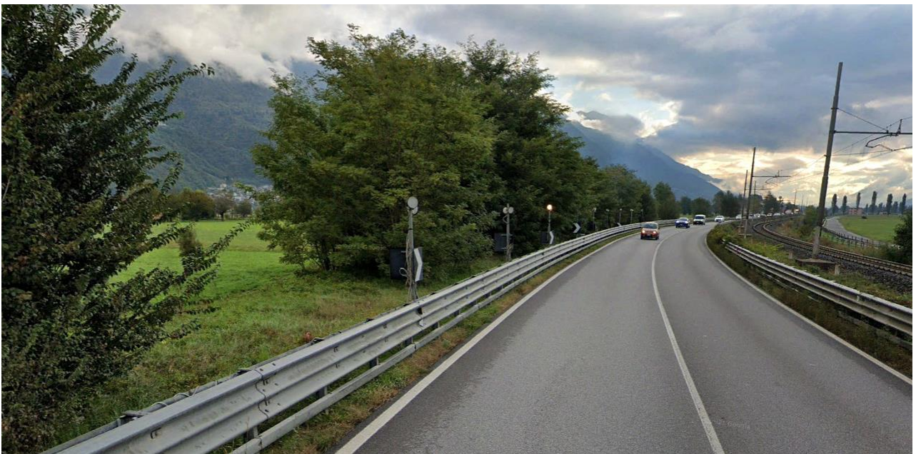
FOTO 4 – Tratta 1: vista della SS38 direzione Tirano. In questo tratto è previsto l'adeguamento con sezione Tipo B per inserimento della banchina laterale e lo spostamento della strada bianca esistente VS01. Sarà necessario il taglio della vegetazione presente (salici nel primo tratto, robinia nel tratto successivo).
