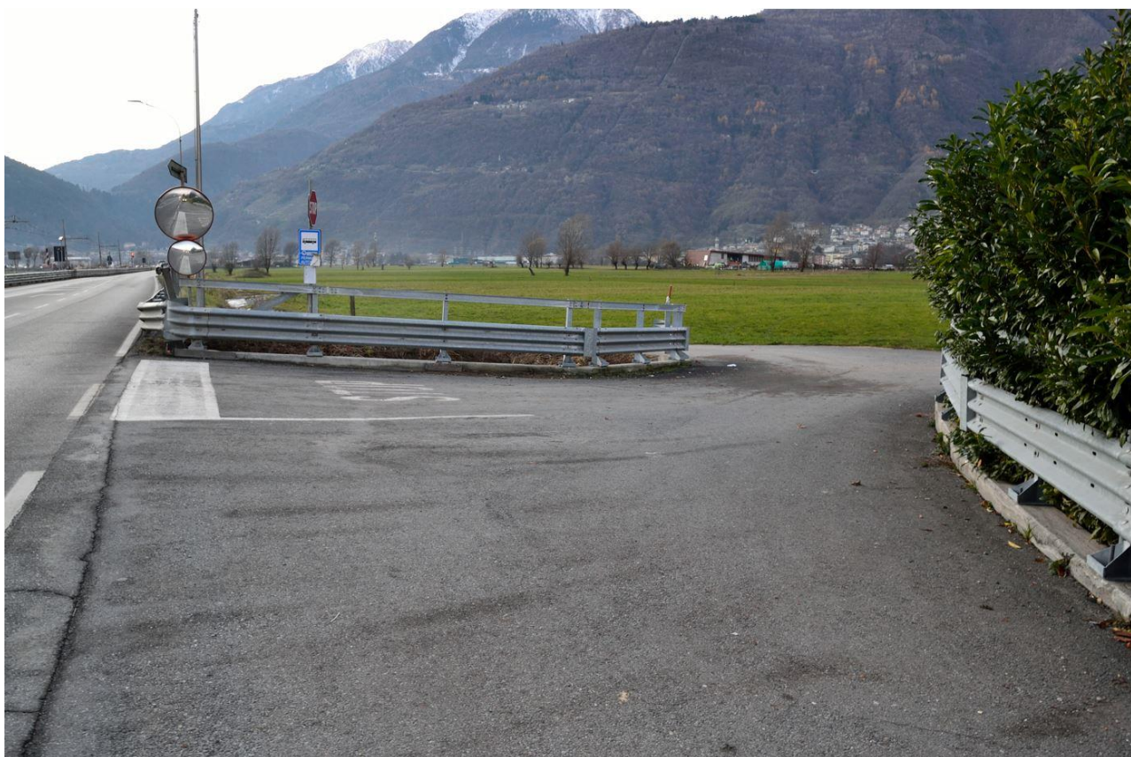
FOTO 6 – Tratta 1: vista della SS38 direzione Colico. In questo tratto è prevista la viabilità secondaria locale VS02.
