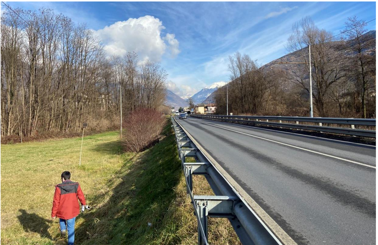
FOTO 8: tratta 3 - Vista della SS38 direzione Tirano. In questo tratto è previsto l'adeguamento con sezione Tipo A per inserimento della banchina laterale.
