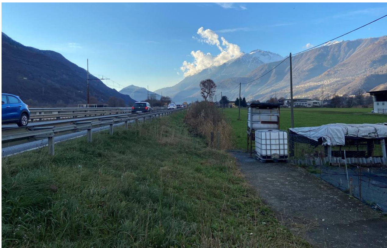
FOTO 9: Vista della SS38 direzione Colico. In questo tratto è previsto l'adeguamento con sezione Tipo E per inserimento della banchina laterale e la realizzazione della strada bianca VS04, con tombinamento del canale esistente.
