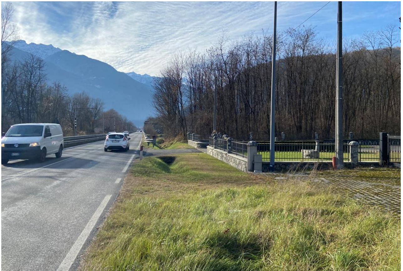
FOTO 9: tratta 3 - Vista della SS38 direzione Colico. In questo tratto è previsto l'adeguamento con sezione Tipo A per inserimento della banchina laterale.
