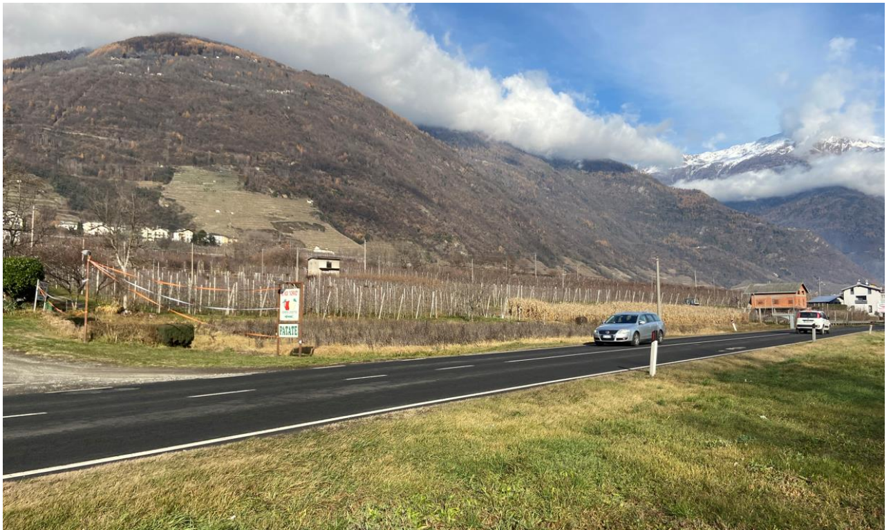
FOTO 5: tratta 4: Vista della SS38 direzione Tirano (vista 4- Tratta 4).
