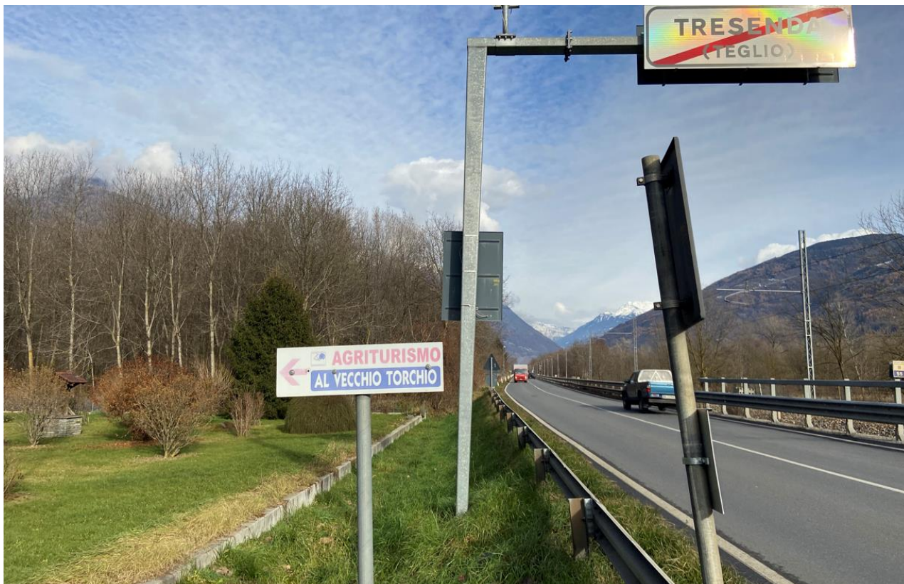
FOTO 1: Tratta 3 - Vista della SS38 direzione Tirano. In questo tratto è previsto l'adeguamento con sezione Tipo A per inserimento della banchina laterale.
