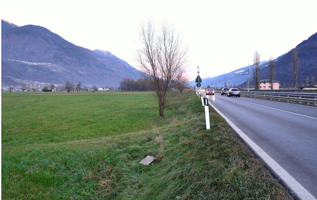
FOTO 8 – Tratta 1: Vista della SS38 direzione Tirano - tratto di connessione della VS03 in progetto. In questo tratto è previsto l'adeguamento con sezione Tipo A.
