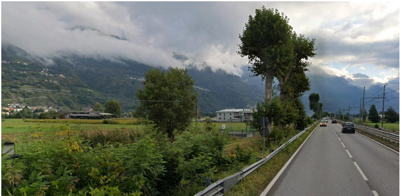
FOTO 1 – Tratta 1: vista della SS38 direzione Tirano. In questo tratto è previsto l'adeguamento con sezione Tipo A per inserimento della banchina laterale. Sarà necessario il taglio del filare di platano esistente a bordo strada.
