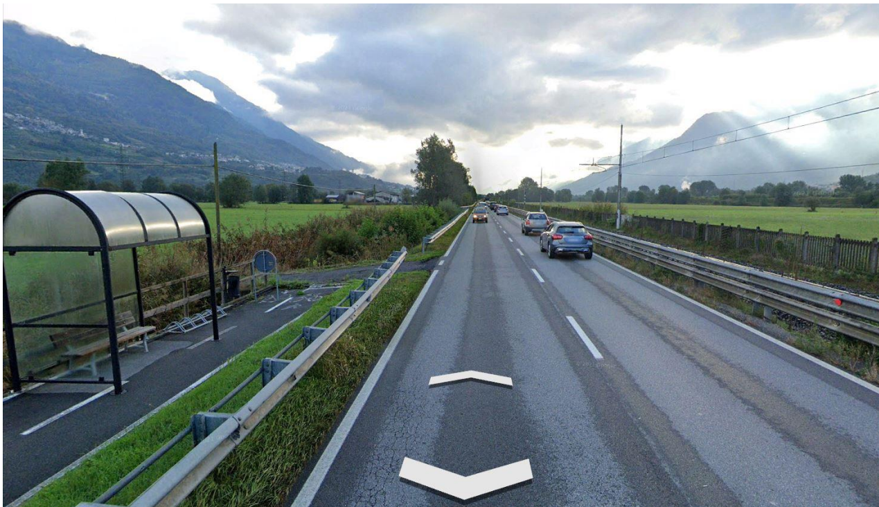
FOTO 1: Tratta 2: vista della SS38 direzione Tirano. In questo tratto è previsto l'adeguamento con sezione Tipo A per inserimento della banchina laterale. All'altezza degli alberi sarà realizzata la strada bianca locale (VS01).
