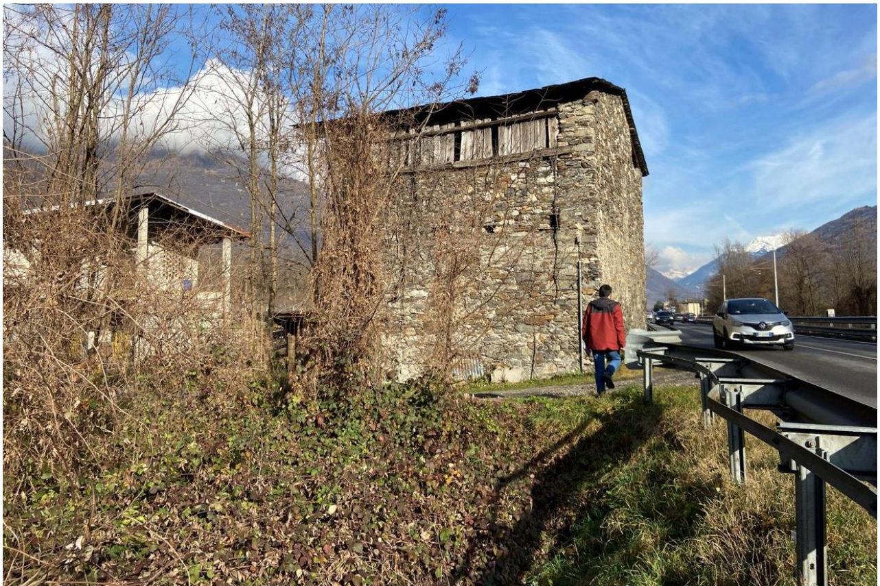
FOTO 6: tratta 3 - Vista dell'edificio interferente da espropriare, direzione Tirano. In questo tratto è previsto l'adeguamento con sezione Tipo C per inserimento della banchina laterale e viabilità secondaria categoria F2.
