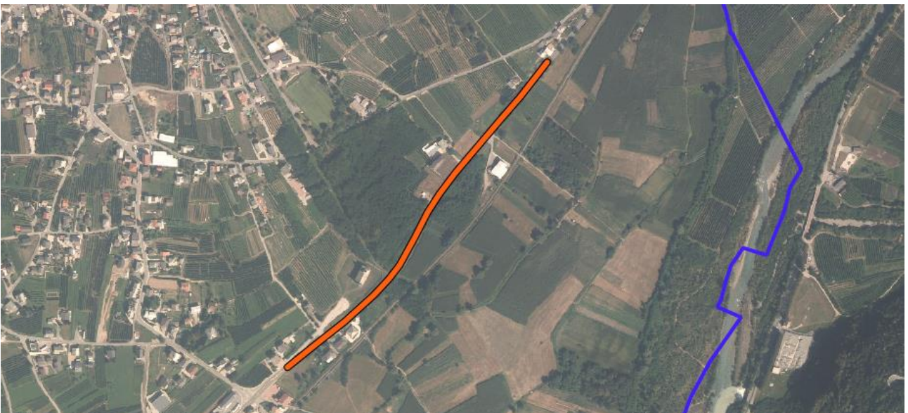
Veduta aerea dell'area oggetto di intervento (Tratta 4) (PNG 2012)
