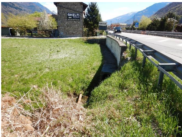
Fig. 1 – Km 23 + 200 altezza via Piani (confine Buglio in Monte – Forcola) da W
