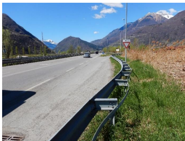
Fig. 2 – Km 23 + 200 da E, svincolo
