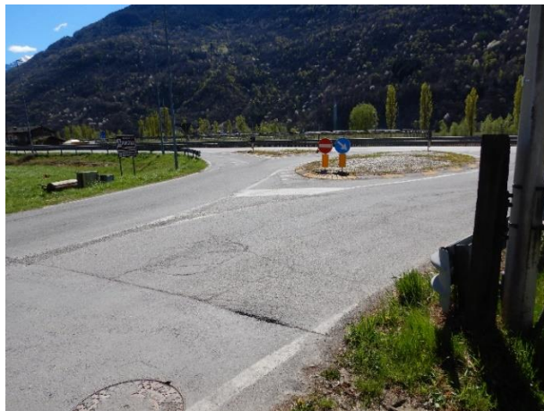
Fig. 8 – Svincolo SP 12 dir A da NW
