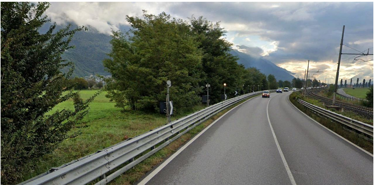
FOTO 4 – Tratta 1: vista della SS38 direzione Tirano. In questo tratto è previsto l'adeguamento con sezione Tipo B per inserimento della banchina laterale e lo spostamento della strada bianca esistente VS01. Sarà necessario il taglio della vegetazione presente (salici nel primo tratto, robinia nel tratto successivo).
