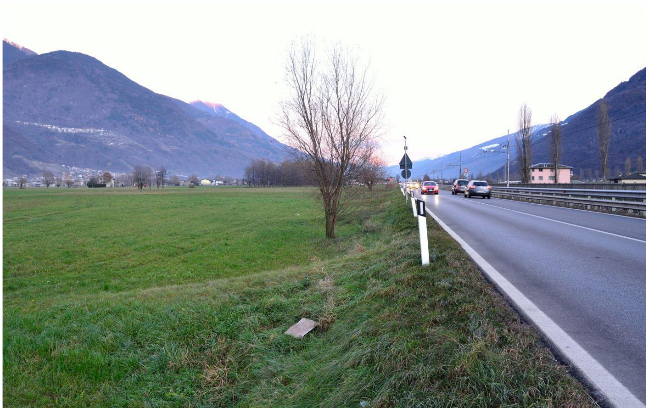
FOTO 8 – Tratta 1: Vista della SS38 direzione Tirano - tratto di connessione della VS03 in progetto. In questo tratto è previsto l'adeguamento con sezione Tipo A.
