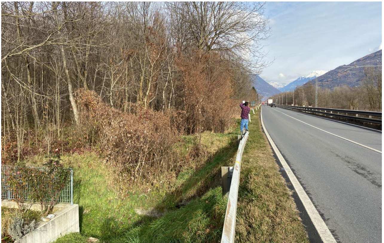
FOTO 2: tratta 3 - Vista della SS38 direzione Tirano. In questo tratto è previsto l'adeguamento con sezione Tipo A per inserimento della banchina laterale.
