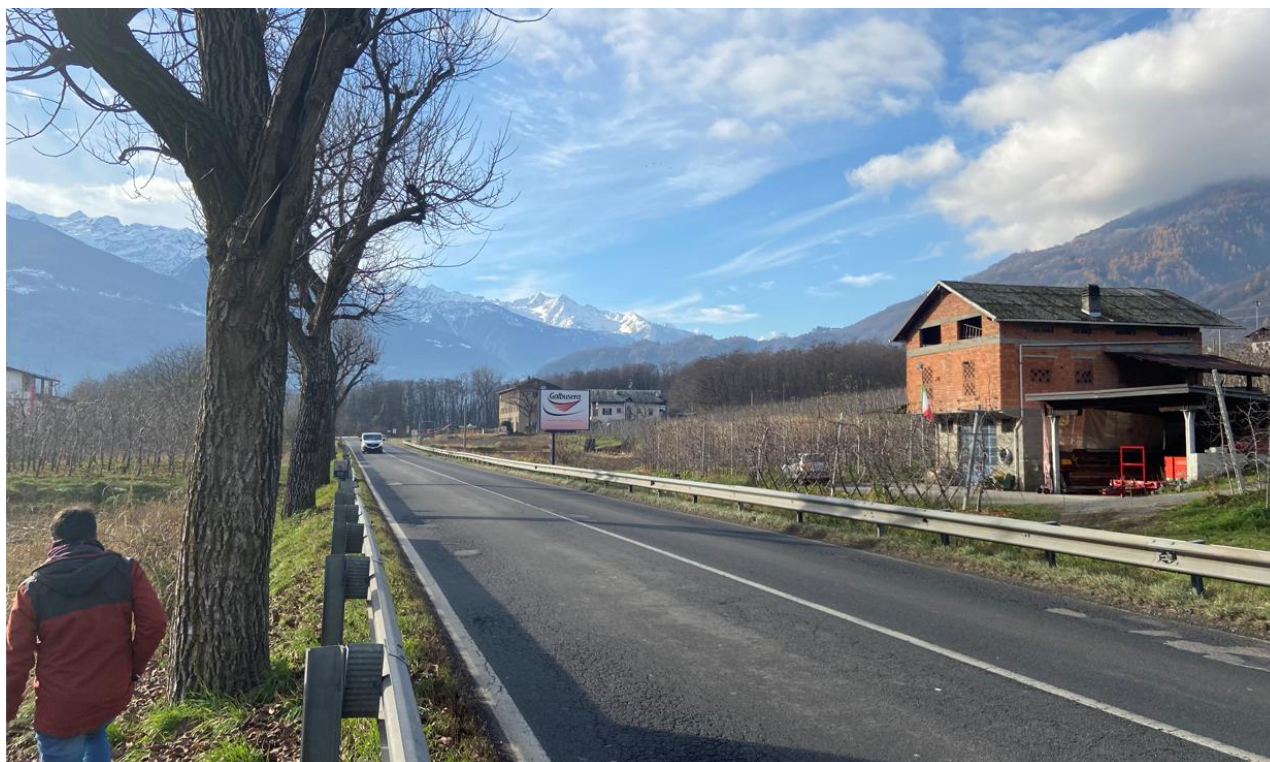
FOTO 7: tratta 4: Vista della SS38 direzione Colico (vista 2- Tratta 4).
