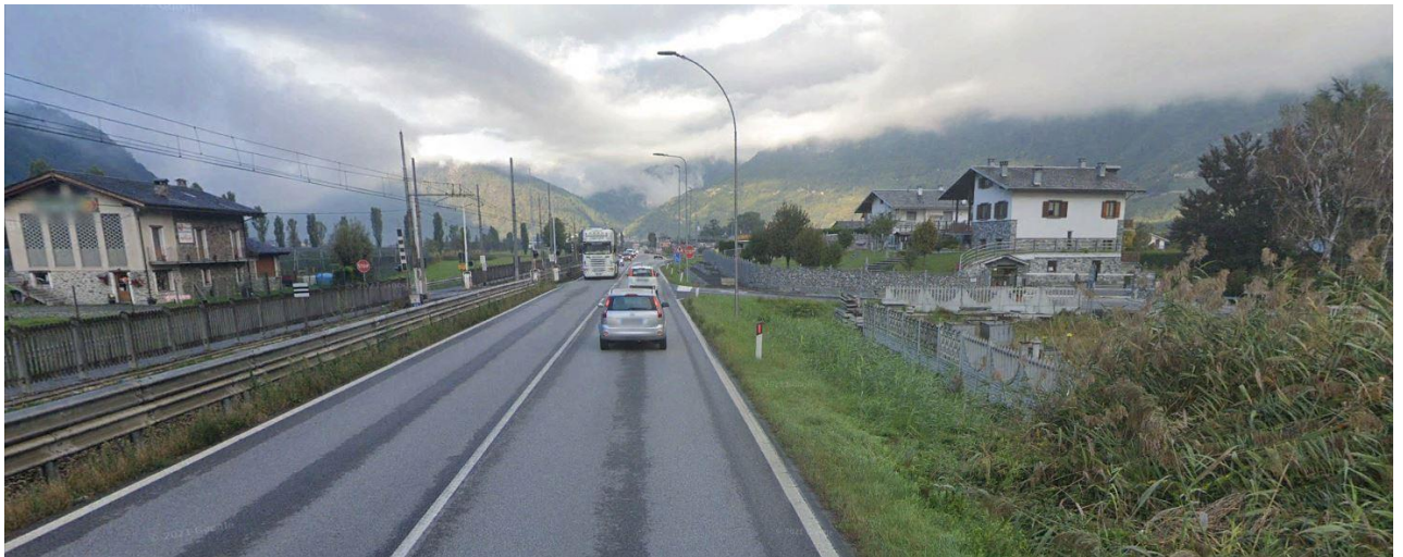
FOTO 14: Tratta 1: Vista della SS38 direzione Colico: sulla destra un'intersezione esistente da chiudere (l'accesso avverrà dall'intersezione TI-I3 più avanti).
