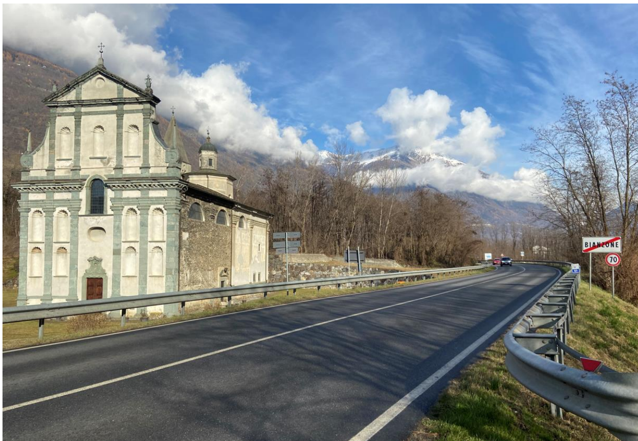
FOTO 1: tratta 4: Vista della SS38 direzione Tirano. Sulla sinistra il santuario della Madonna del Piano. In lontananza l'inizio della tratta di SS38 oggetto di intervento.
