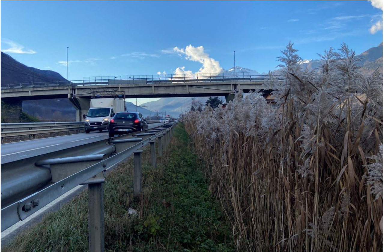
FOTO 13: Vista della SS38 direzione Colico. In questo tratto è previsto l'adeguamento con sezione Tipo A per inserimento della banchina laterale.
