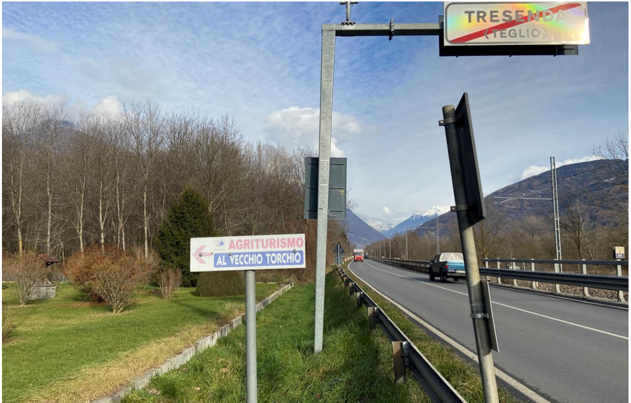
FOTO 1: Tratta 3 - Vista della SS38 direzione Tirano. In questo tratto è previsto l'adeguamento con sezione Tipo A per inserimento della banchina laterale.
