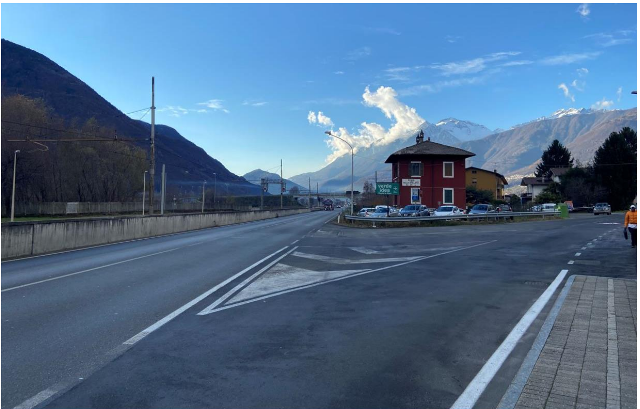
FOTO 16: Vista della SS38 direzione Colico. In questo tratto è previsto l'adeguamento con sezione Tipo A per inserimento della banchina laterale.
