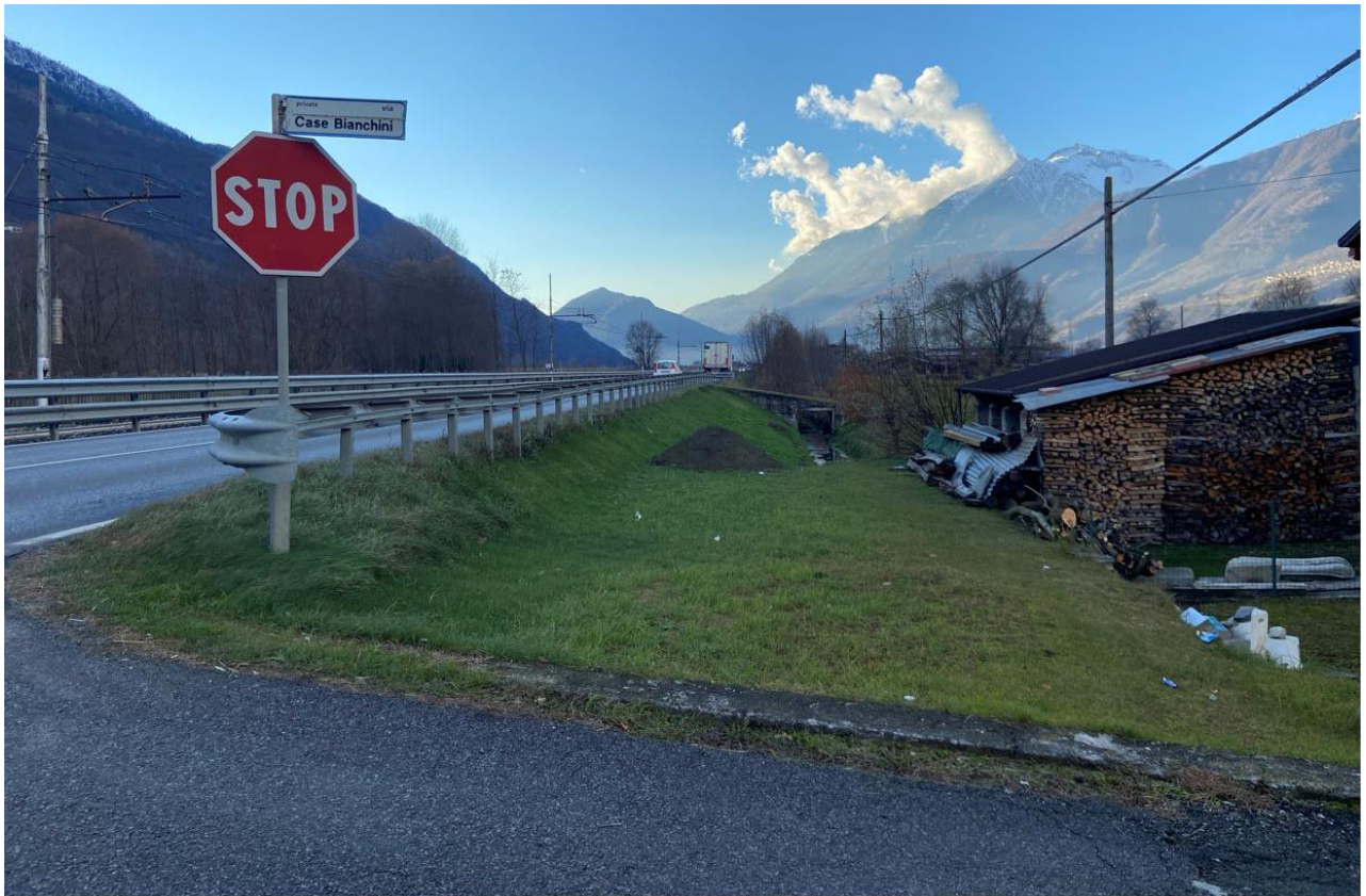
FOTO 5: Tratta 2: Vista della SS38, direzione Colico. In questo tratto è previsto l'adeguamento con sezione Tipo A per inserimento della banchina laterale; più avanti sarà realizzata la VS02.
