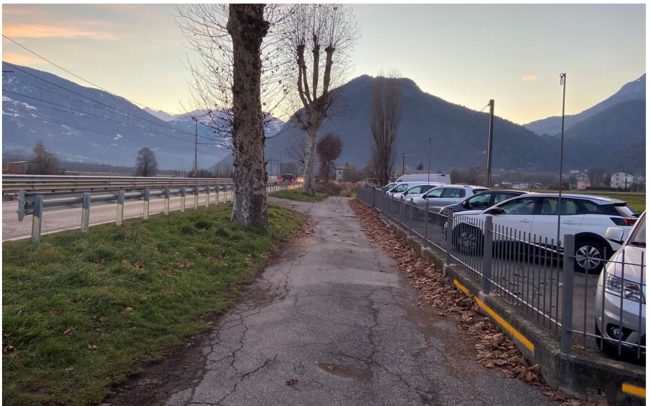
FOTO 2 – Tratta 1: Vista della SS38 direzione Colico. In questo tratto è previsto l'adeguamento con sezione Tipo A per inserimento della banchina laterale. Sarà necessario il taglio del filare di platano esistente a bordo strada
