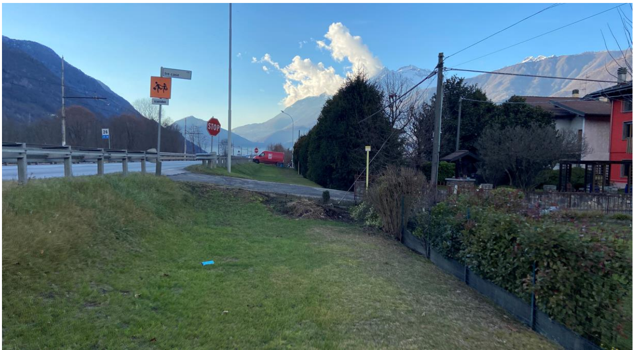
FOTO 7: Tratta 2: Vista dell'accesso dalla SS38 alla nuova viabilità locale, direzione Colico. In questo tratto è previsto l'adeguamento con sezione Tipo A per inserimento della banchina laterale e la chiusura degli accessi diretti.
