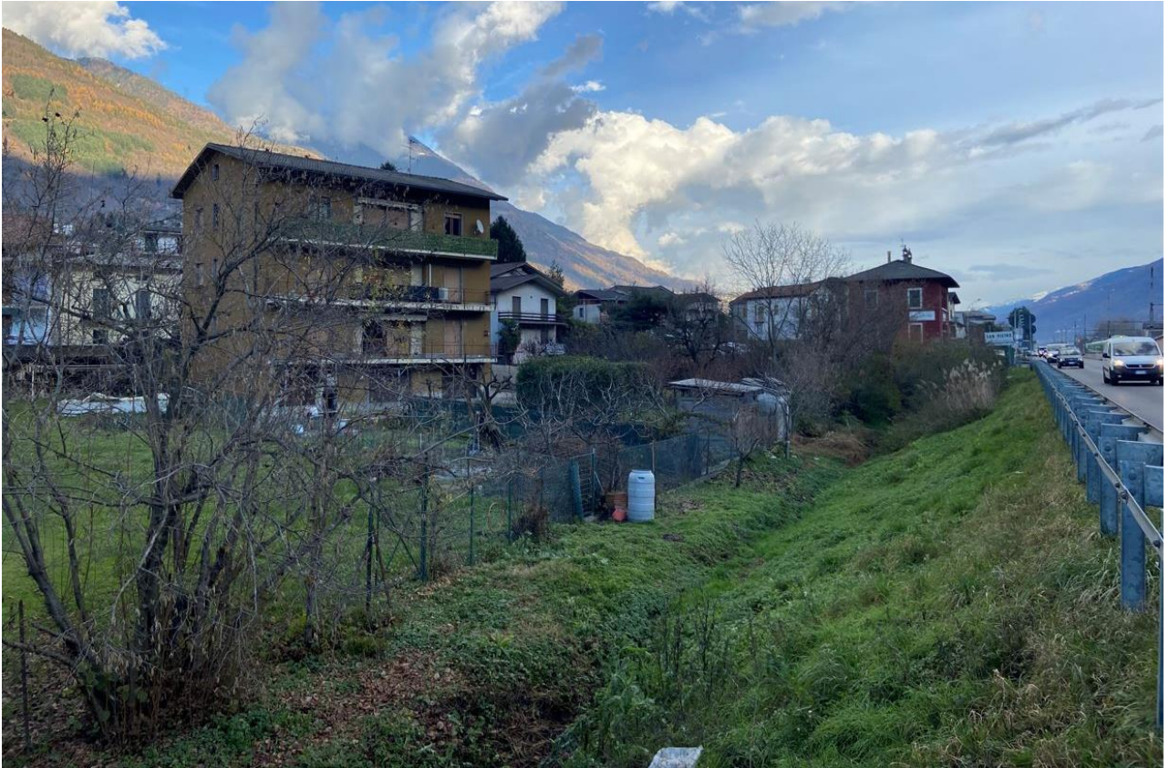
FOTO 15: Vista della SS38 direzione Tirano. In questo tratto è previsto l'adeguamento con sezione Tipo A per inserimento della banchina laterale.
