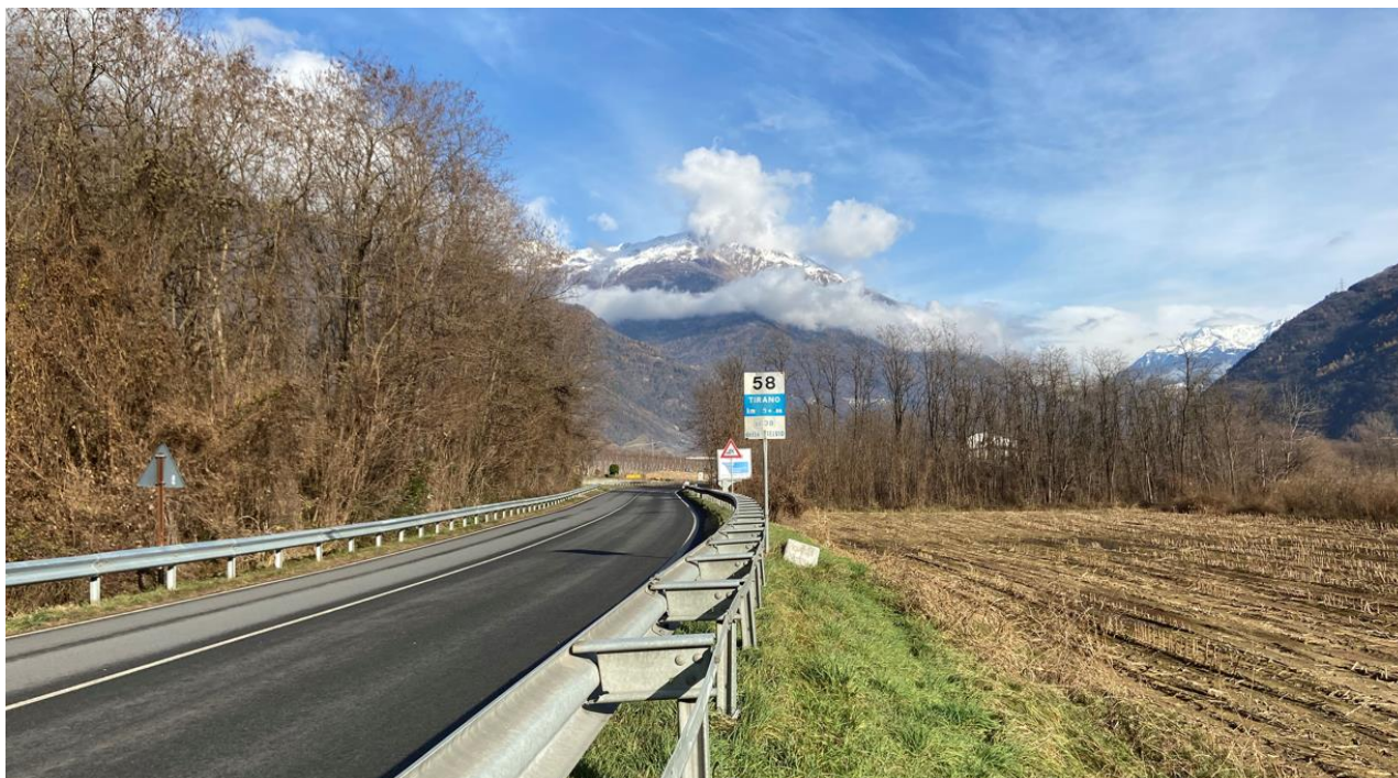
FOTO 3: tratta 4: Vista della SS38 direzione Tirano
