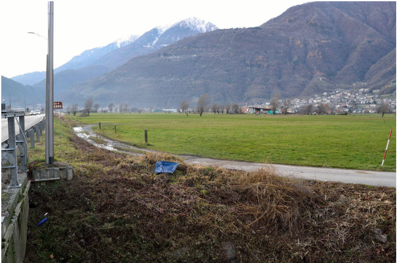
FOTO 6a – Tratta 1: vista ravvicinata direzione Colico. In questo tratto è prevista la viabilità secondaria locale VS02.
