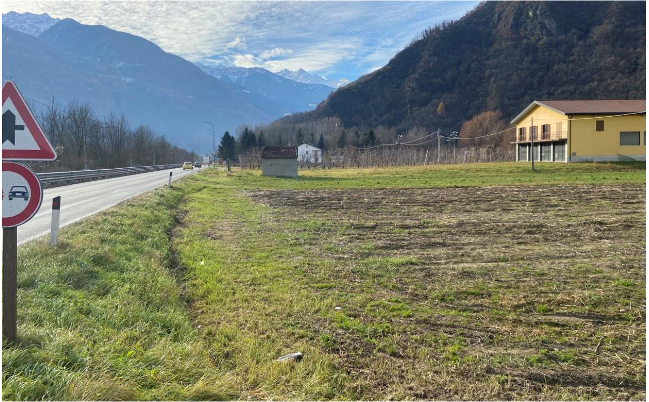
FOTO 5: tratta 3 - Vista della SS38 direzione Colico dove è prevista l'intersezione T3-II. In questo tratto è previsto l'adeguamento con sezione Tipo B.
