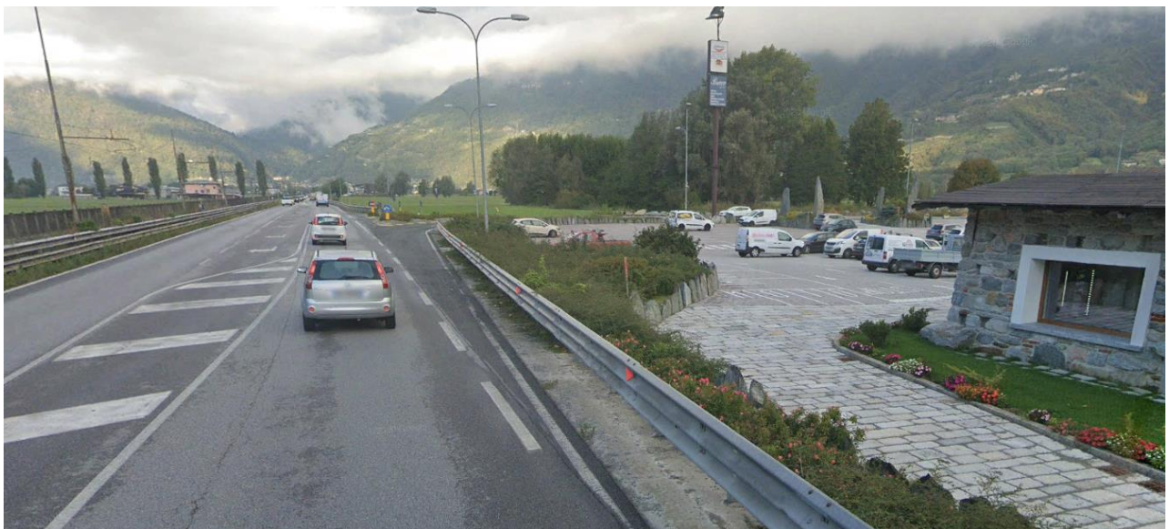
FOTO 11 – Tratta 1: Vista della SS38 direzione Colico in corrispondenza del complesso "La Brace" dove è prevista la nuova intersezione TI-I2. In questo tratto è previsto l'adeguamento con sezione Tipo D.
