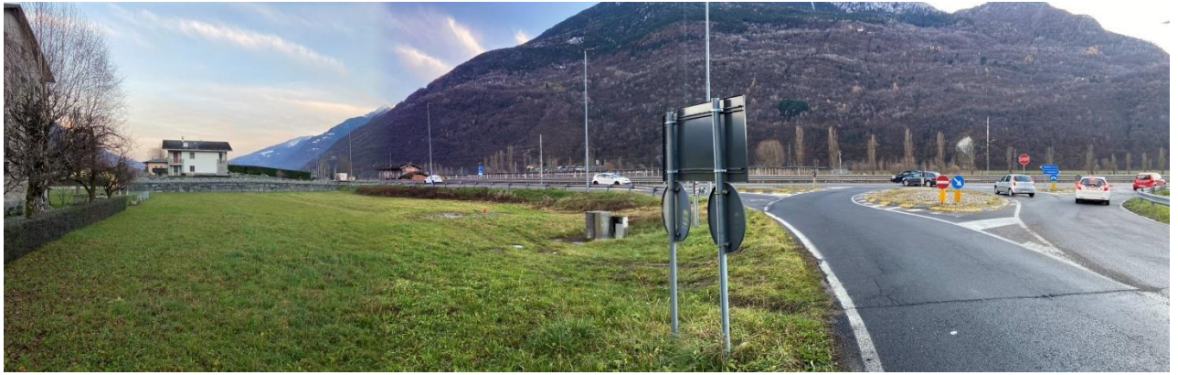
FOTO 14: Vista della SS38 direzione Tirano, dell'intersezione da adeguare.
