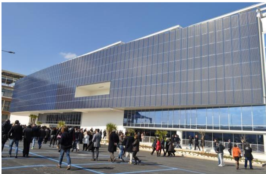
Fig. 5 : Aeroporto di Atene con impianto fotovoltaico.
