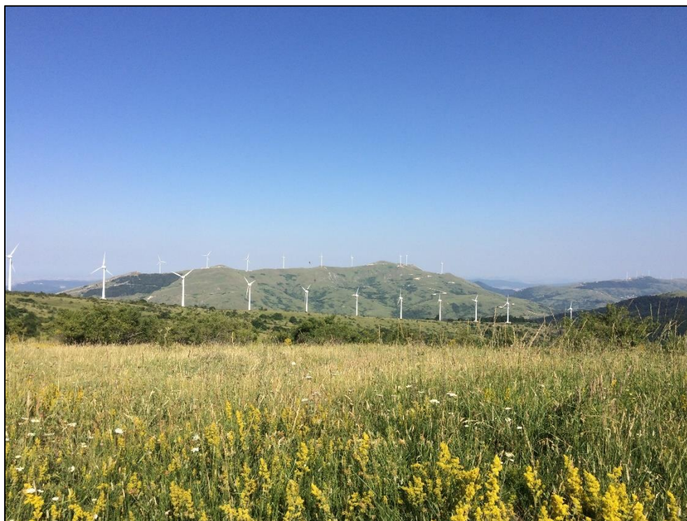
Figura 4.5: Dettaglio panoramico dell'impianto esistente (zona Sud)
