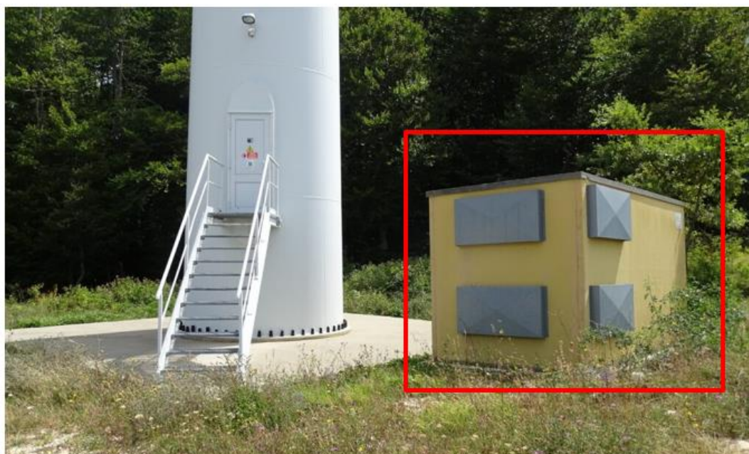
Figura 6.7: Aspetto delle strutture esistenti. Dettaglio rimozione dell'impianto tecnologico (nel quadrato rosso)
